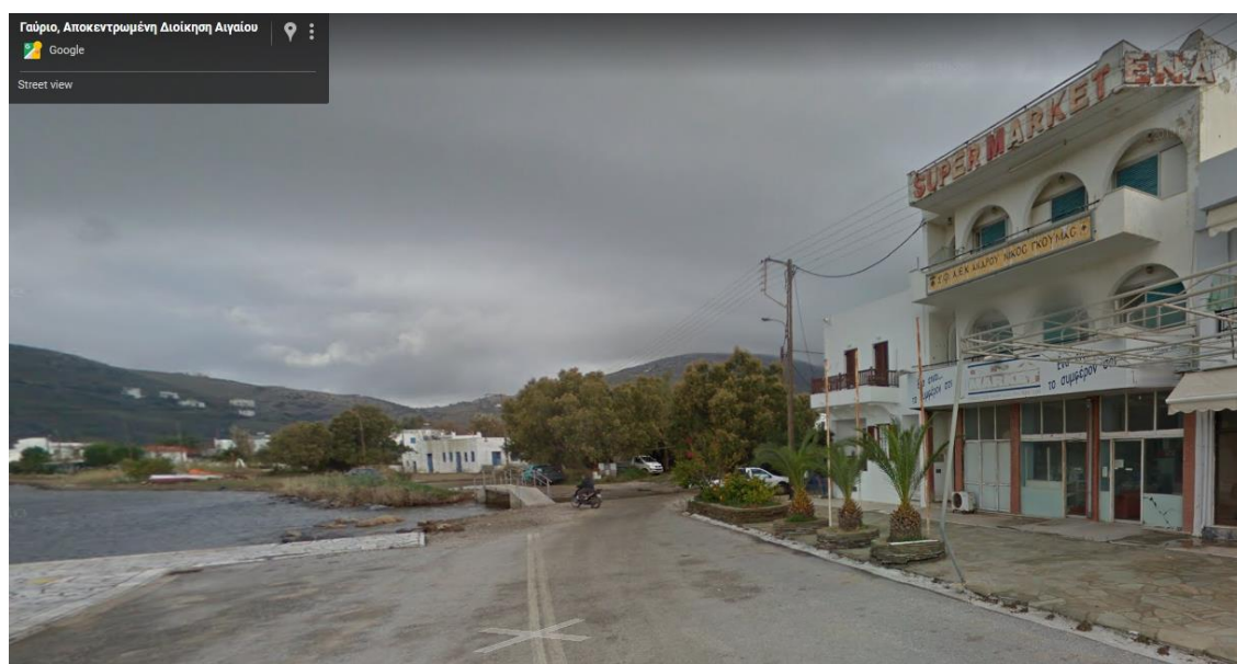
Σχήμα 6. 1: Πρόσωση του κτιρίου στην παραλιακή οδό Γαυρίου, Άνδρος (Πηγή: google maps)
