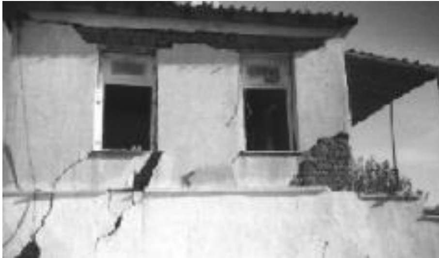
Σχήμα 2. 9: Διατμητική βλάβη τοιχίων (Πηγή: http://teicm.panagop.com/files/ferousa/yliko/Sarigianni/7o_Mathima.pdf )
