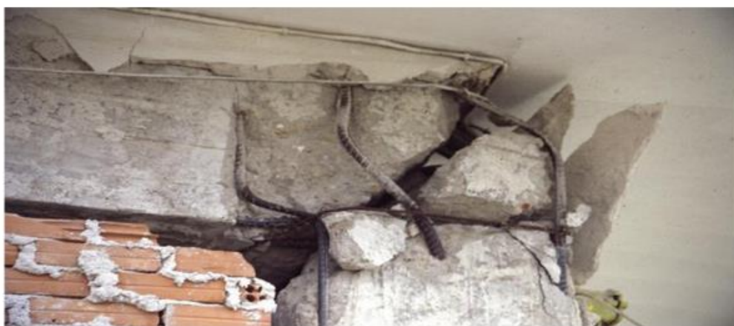
Σχήμα 2. 7: Αστοχία εξωτερικού κόμβου και πρακτική απόλεια στήριξης
