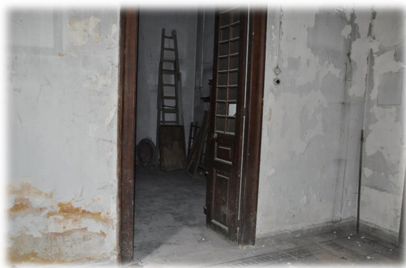
Εικόνα 3.31. Θύρα μετάβασης από το χολ στο βοηθητικό χώρο 1, στο ισογείο.
