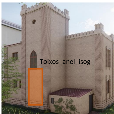
Σχήμα 5.39. Πρώτη αστοχία σε διάτμηση, της δεύτερης καταγραφής - πίσω όψη
