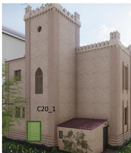
Σχήμα 5.34 Αστοχία του στοιχείου σε ροπή κάμψης, της πρώτης καταγραφής - πίσω όψη
