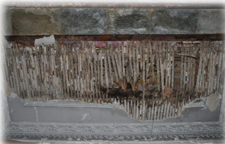
Εικόνα 3.29. Ξυλότυπος χολ ισογείου.
