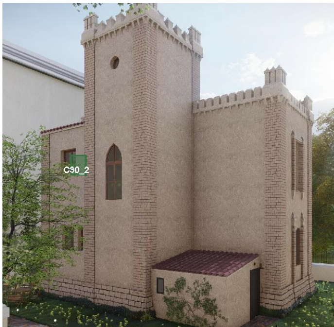
Σχήμα 5.6. Αστοχία του στοιχείου σε ροπή κάμψης– πίσω όψη
