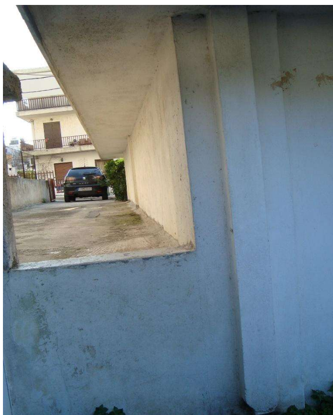
ΕΙΚΟΝΑ 4.48: Η K9 και K18, K27 στο βάθος, όπως είναι σήμερα. Τα μεταξύ τους φατνώματα κλεισμένα με τοίχειο. Το υπερυψωμένο κομμάτι χρησιμοποιείται, όπως και παλαιότερα, σαν χώρος στάθμευσης.
