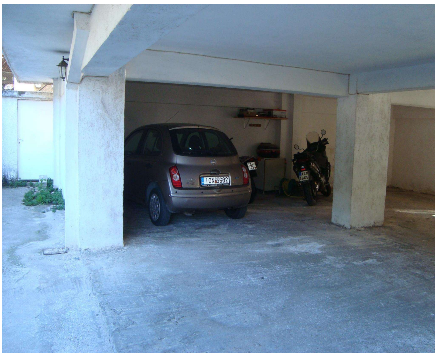
ΕΙΚΟΝΑ 4.50: Στο βάθος, δεξιά από τη ραφιέρα, διακρίνεται η Κ18 ανάμεσα στα κλειστά πλέον φατνώματα. Η λευκή πόρτα στο διάδρομο αριστερά, είναι η ίδια με αυτή που φαίνεται στις εικόνες 4.41 & 4.42 (στο σεισμό του '99 ήταν κόκκινη).
