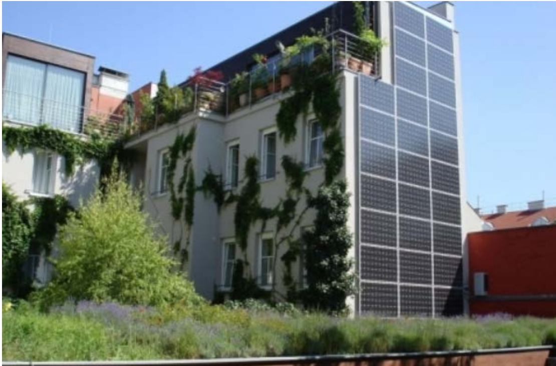
Εικόνα 3.3-1 Boutique Hotel Stadthalle
