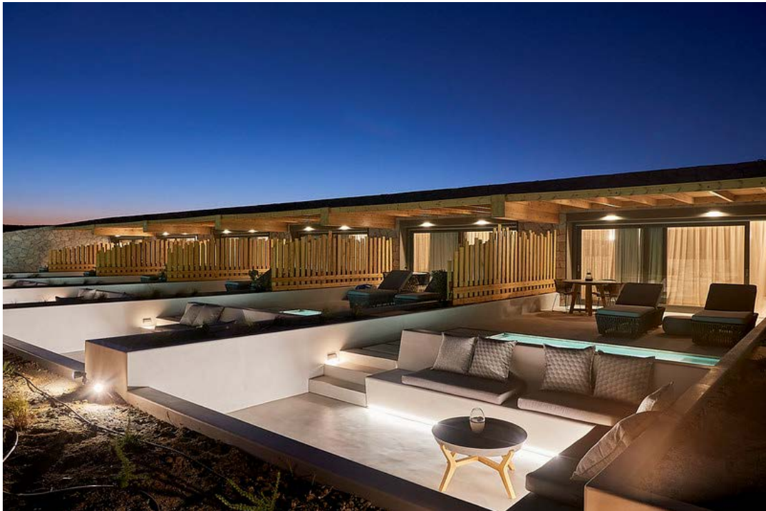
Εικόνα 5.1-8 Τελική εξωτερική όψη Δωματίων
