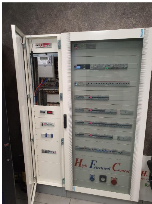
Εικόνα 83 Ηλεκτρολογικός Πίνακας H.E.C. systems - Έξυπνοι μετρητές ATLAS Mk10A και SM21
