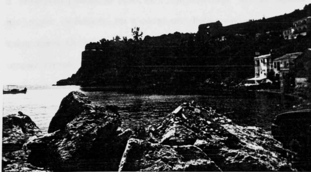
Εικόνα 1.1.: Άποψη του κάστρου από το λιμάνι
