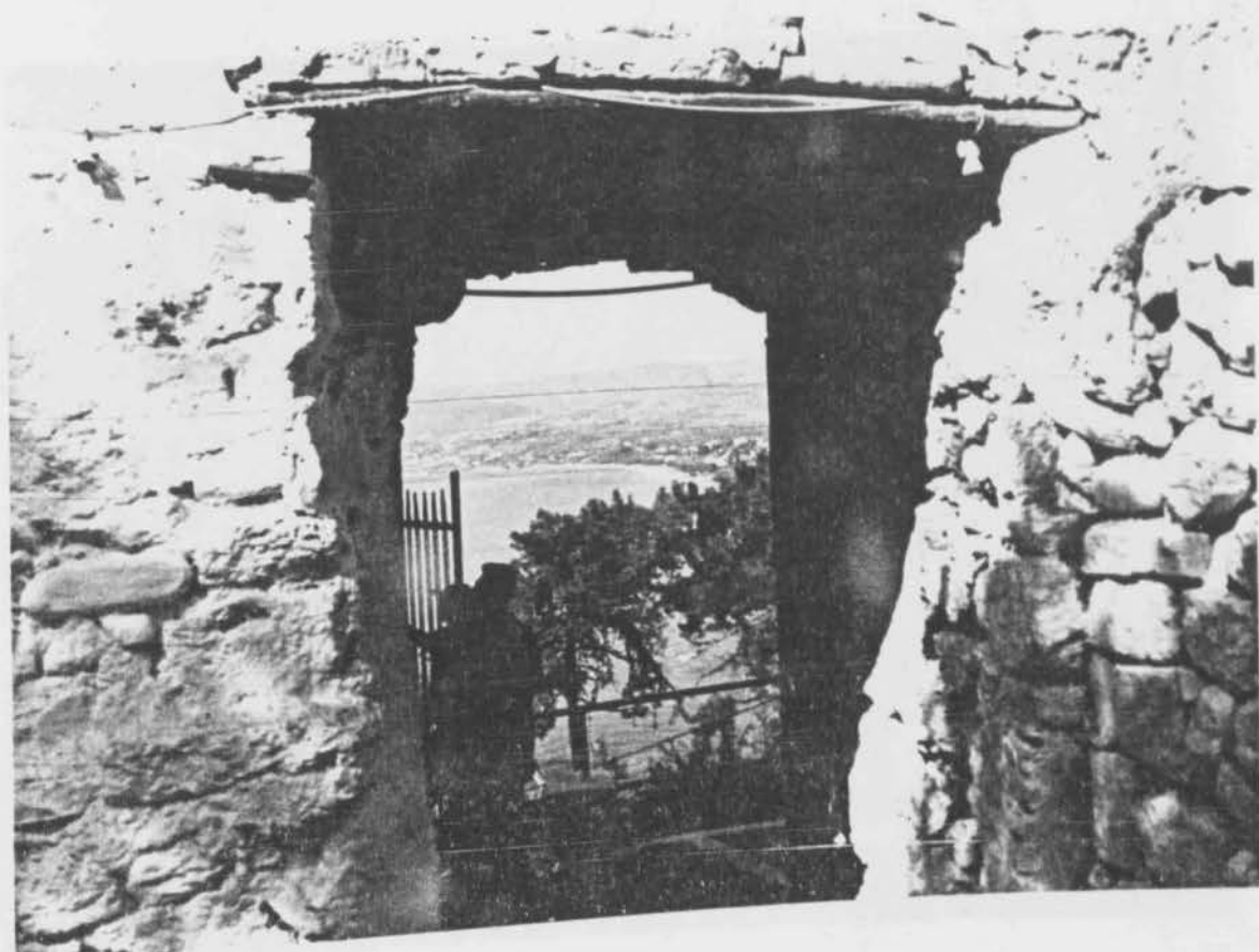
Εικόνα 3.49.: Η έξοδος στο νότιο τμήμα του κάστρου.
