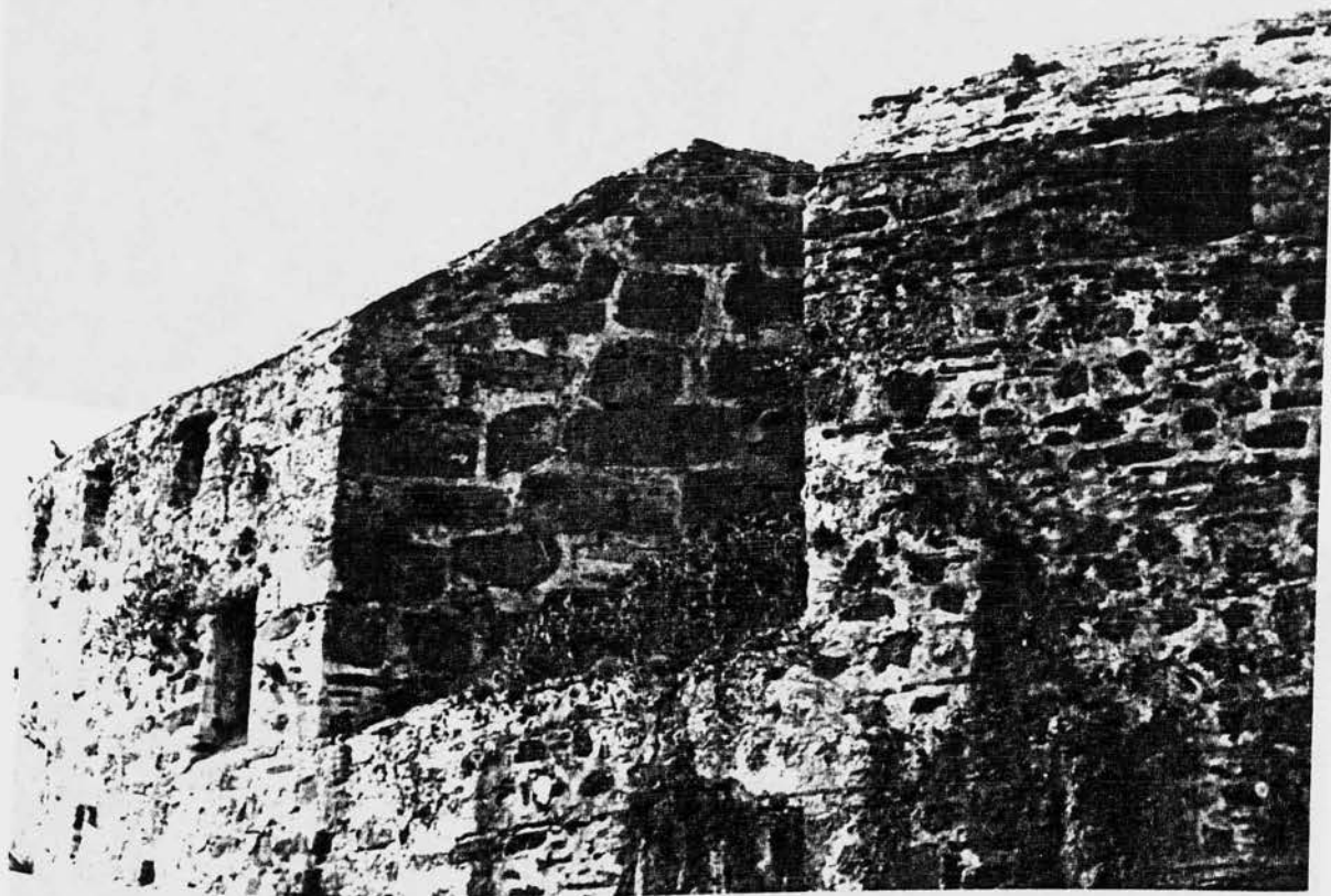
Εικόνα 3.22.: Λεπτομέρεια της οροφής-ευδιάκριτη η κλίση των τειχών για των εξοστρακισμό των βλημάτων.
