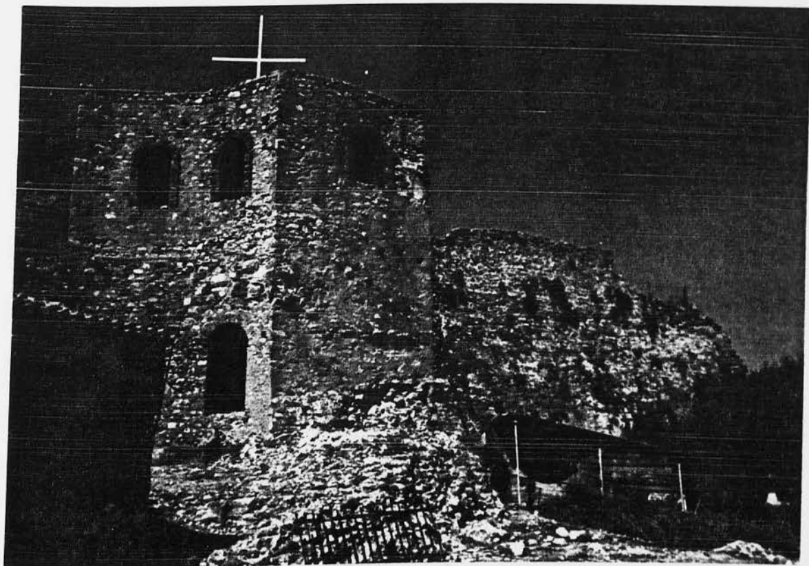
Εικόνα 3.39.: “Ημεγάλη Ντάπια”. Ο ψηλότερος προμαχώνας του κάστρου χτισμένος πάνω στις παλιές αποθήκες.
