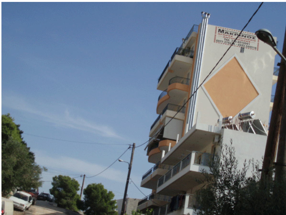
Άποψη νεόκτιστης πολυκατοικίας στα όρια της περιοχής Ικαριώτικα
