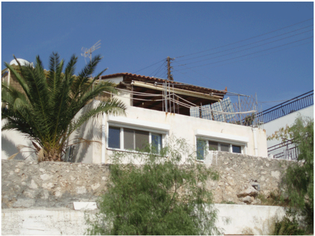
Άποψη μονοκατοικίας στα 'Ικαριώτικα' Περάματος
