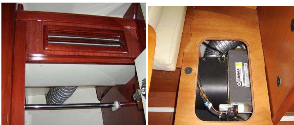
Εικόνα 14 Στοιχεία συστήματος Fan Coil
