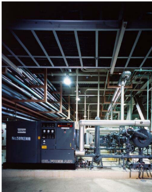
Εικόνα 6.8.2 Δίκτυο διανομής πεπιεσμένου αέρα
