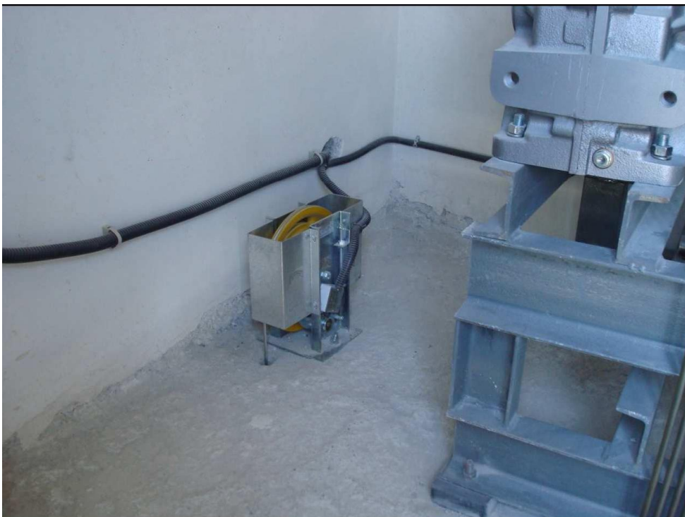
Εικόνα 9 Περιοριστήρας Ταχύτητας
