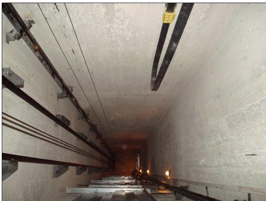
Εικόνα 7 Μορφή εύκαμπτου καλωδίου ανελκυστήρα
