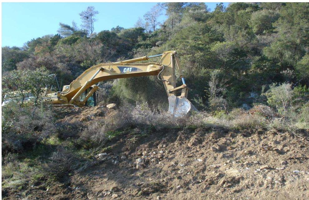
Φωτ.1. Διαμόρφωση επιπέδου εργασίας
