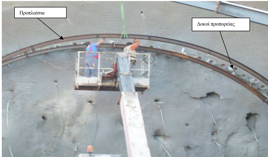
Φωτ.7. Τοποθέτηση προπλαισίων.
