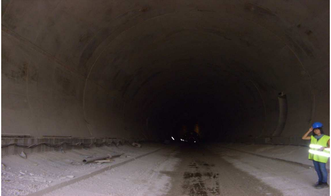
Φωτ.22 σταδιακές σκυροδετήσεις θόλου στο βάθος ο μεταλλότυπος
