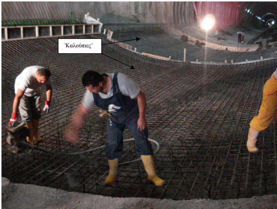
Φωτ.16.Σκυροδέτηση ανάστροφου τόξου ( invert)
