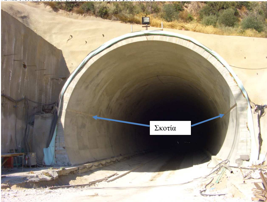
Φωτ.21.μονιμη επένδυση σήραγγας μετά την αφαίρεση του μεταλλότυπου.
