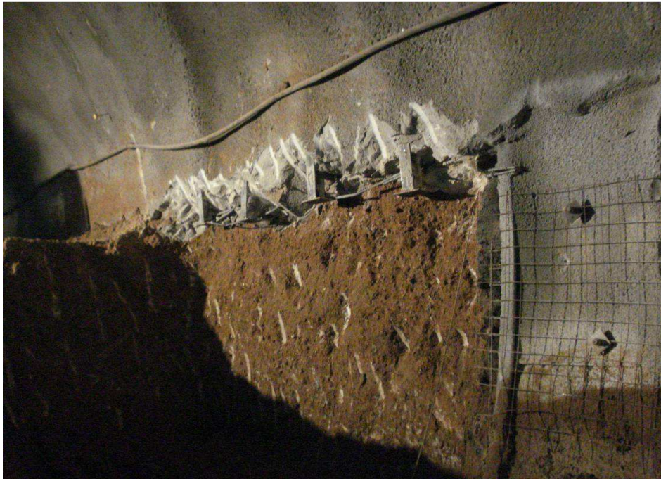
Φωτ.13. Εκσκαφή Β΄ φάσης, τοποθέτηση τελευταίου τμήματος του πλαισίου.
