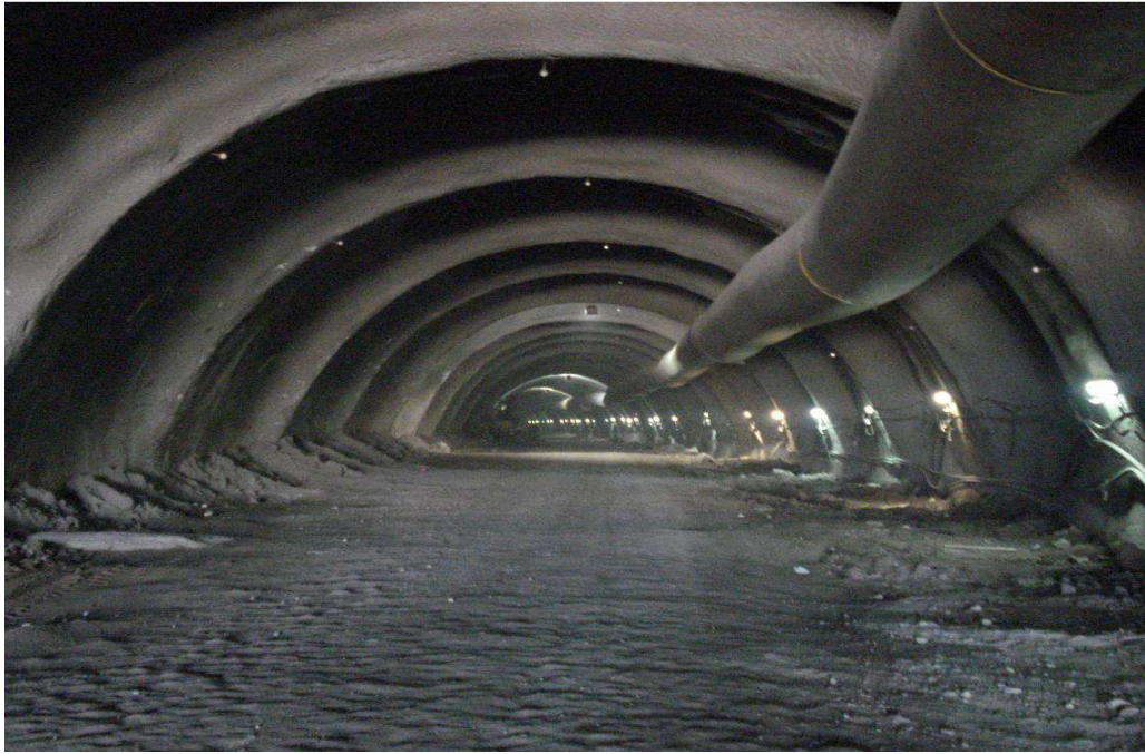
Φωτ.10. ολοκλήρωση Α΄ φάσης εκσκαφών.
