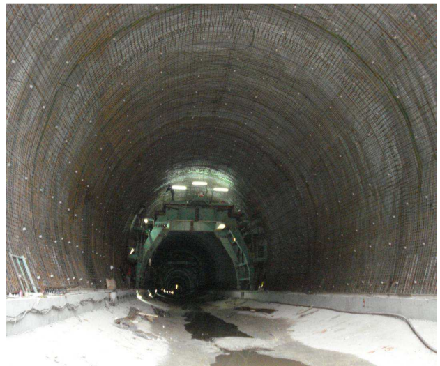
Φωτ.18. Τοποθέτηση οπλισμού θόλου.
