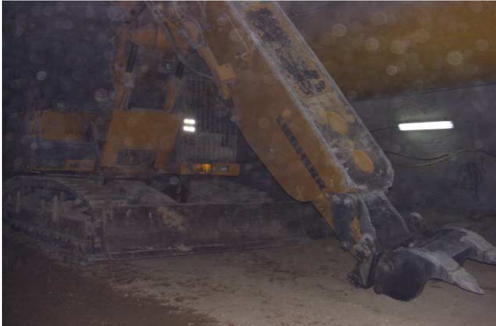
Φωτ.6 εκσκαφέας ή ΔΡΑΚΟΣ.
