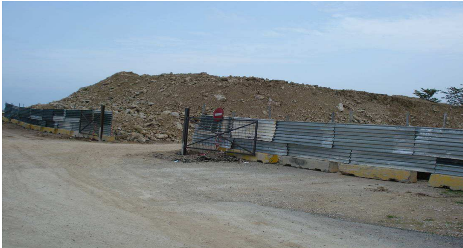
Φωτ.5. Χώρος απόθεσης αποκομιδής προϊόντων εκσκαφής
