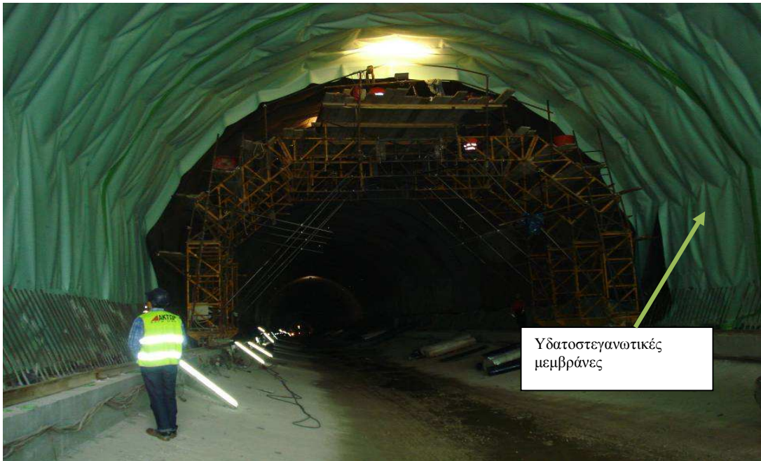
Φωτ.15.Τοποθέτηση Υδατοστεγανωτικής Μεμβράνης
