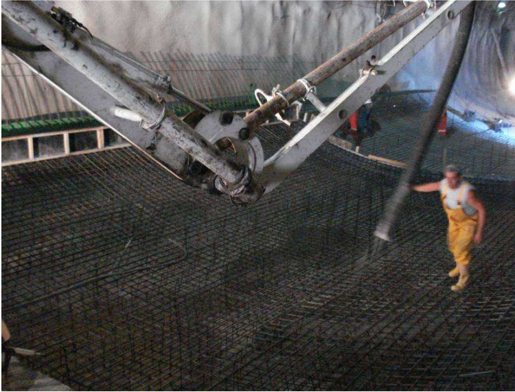
Φωτ.17. Σκυροδέτηση ανάστροφου τόξου (invert)
