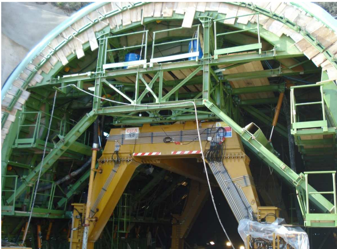
Φωτ.20.Μεταλλότυπος (καλούπι) για την σκυροδέτηση του θόλου της σήραγγας.
