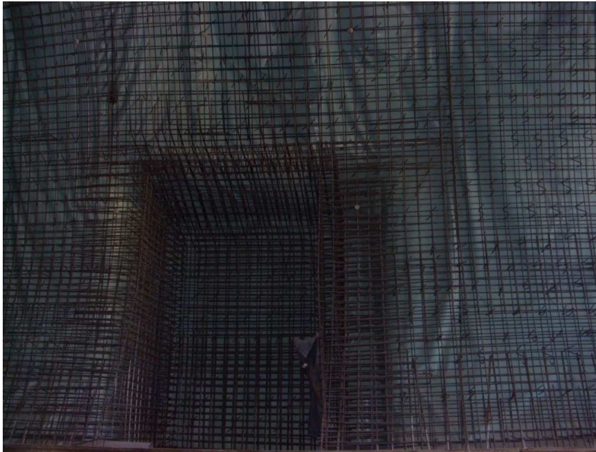
Φωτ.19 οπλισμός εσοχής
