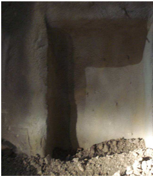
Φωτ.14. εσοχές που εξυπηρετούν ηλεκτρομηχανολογικές εγκαταστάσεις.
