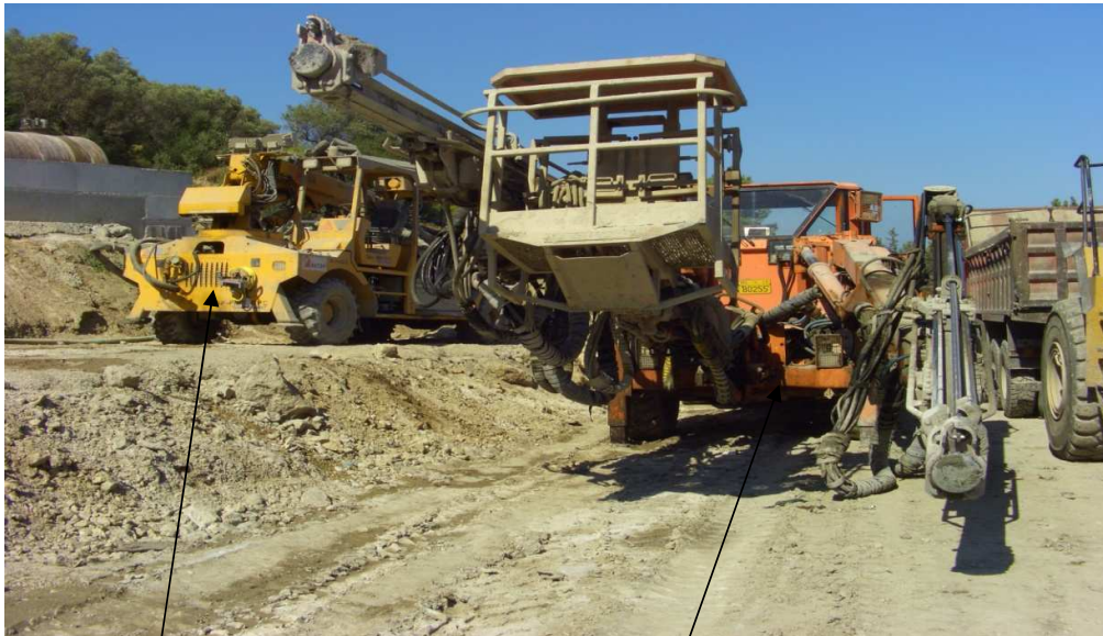
φωτ.3. αριστερά πρέσα εκτοξευόμενου σκυροδέματος, δεξιά διατρητικό μηχάνημα.
