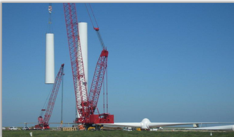
Σχήμα 10.27 Τμηματική τοποθέτηση πύργου ανεμογεννήτριας.
