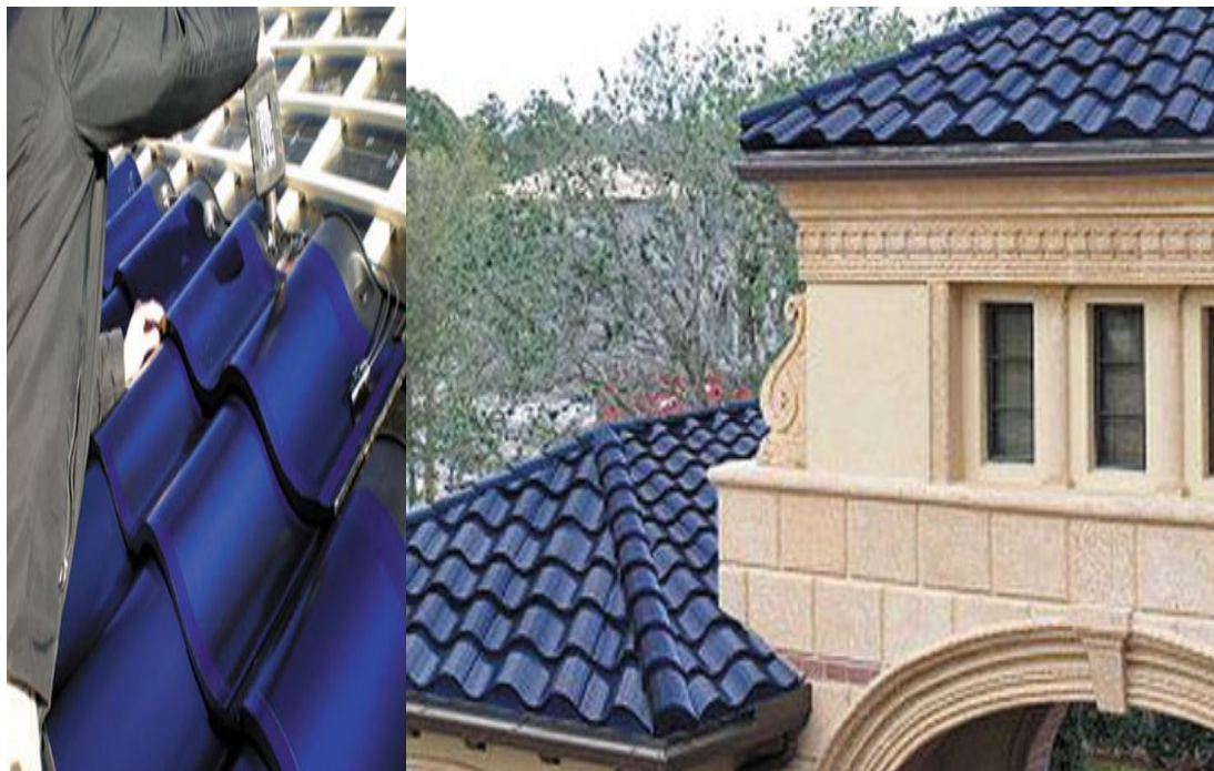
Σχήμα 5.2 Πάνω αριστερά η τοποθέτηση και πάνω δεξιά η ολοκλήρωση της εγκατάστασης, με τη χρήση φωτοβολταϊκών πλαισίων, με τη μορφή κεραμιδιών.
