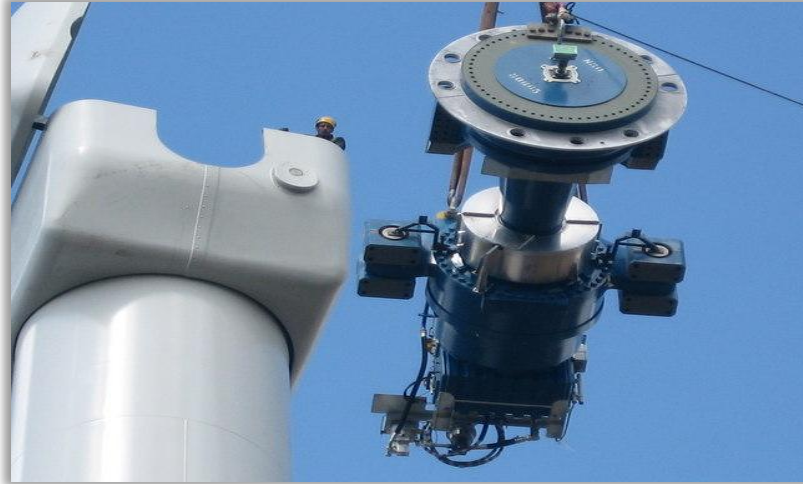
Σχήμα 10.31 Τοποθέτηση εξαρτημάτων στην άτρακτο της ανεμογεννήτριας.
