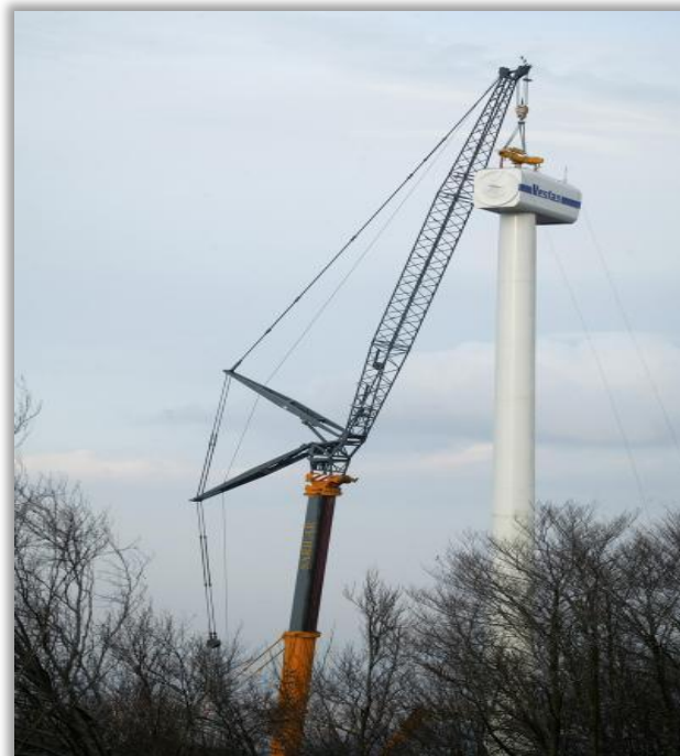
Σχήμα 10.32 Τοποθέτηση της ατράκτου στην κορυφή της ανεμογεννήτριας με τη βοήθεια ειδικού γερανού ανύψωσης.
