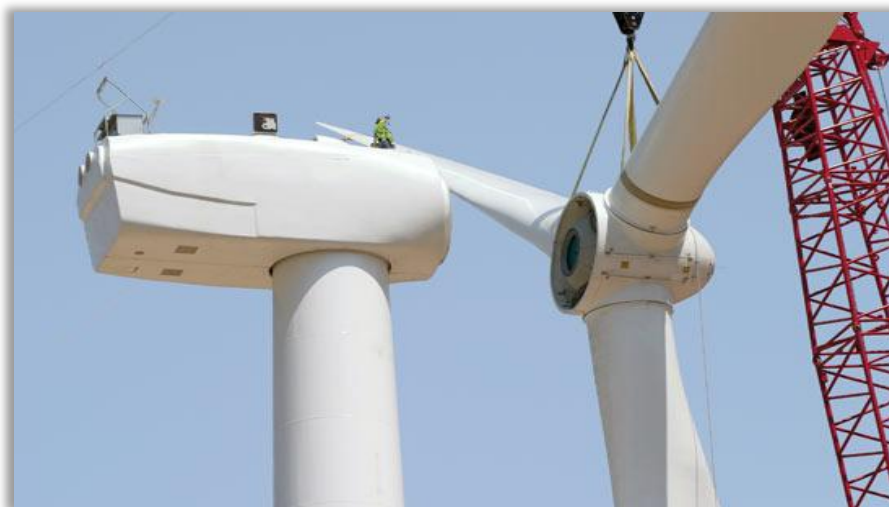
Σχήμα 10.33 Τοποθέτηση ρότορα στην άτρακτο της ανεμογεννήτριας.
