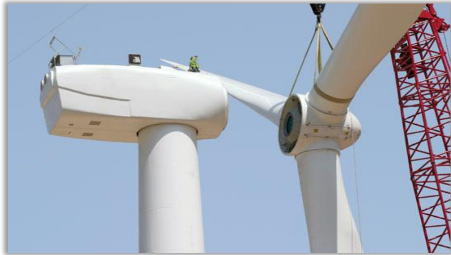
Σχήμα 10.33 Τοποθέτηση ρότορα στην άτρακτο της ανεμογεννήτριας.
