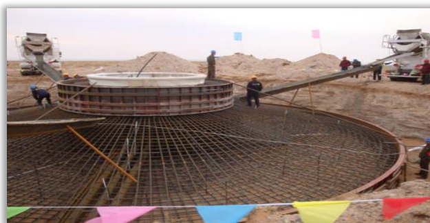
Σχήμα 10.25 Κατασκευή βάσης στήριξης ανεμογεννήτριας από οπλισμένο σκυρόδεμα.
