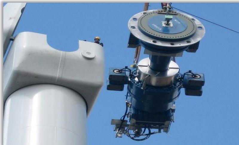
Σχήμα 10.31 Τοποθέτηση εξαρτημάτων στην άτρακτο της ανεμογεννήτριας.
