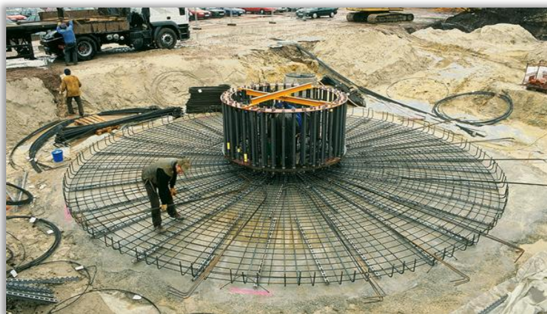
Σχήμα 10.26 Θεμελίωση πύργου ανεμογεννήτριας.
