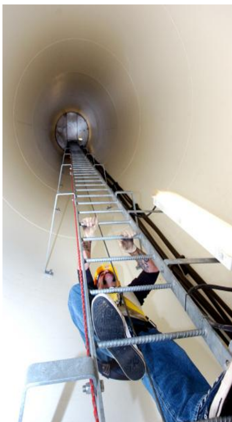
Σχήμα 10.22 Εσωτερική σκάλα πρόσβασης σε σωληνωτό πύργο ανεμογεννήτριας – ειδικός γερανός ανέγερσης πύργου ανεμογεννήτριας
