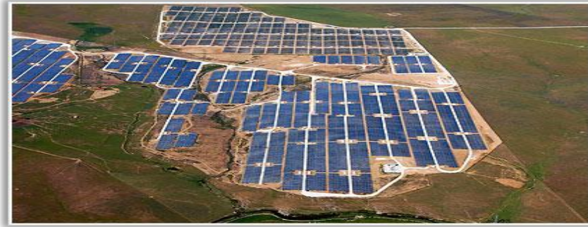
Σχήμα 1.8 Αεροφωτογραφία Φωτοβολταϊκού πάρκου, 8,3 MW p , στην δημοτική ενότητα Καλυβίων του δήμου Τρικάλων.
