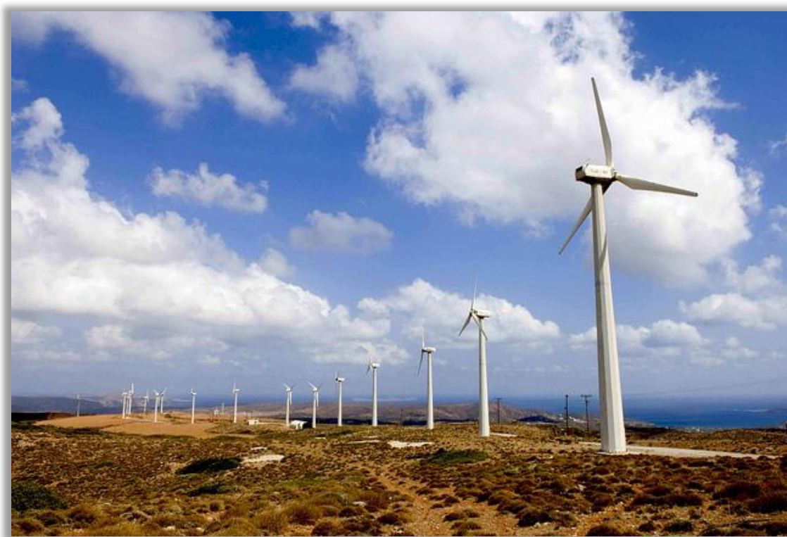
Σχήμα 1.6 Αιολικό πάρκο Μονής Τοπλού στην Σητεία της Κρήτης συνολικής ισχύος 6,6 MW.
