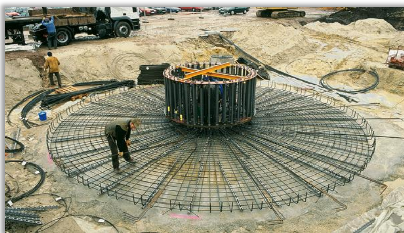
Σχήμα 10.26 Θεμελίωση πύργου ανεμογεννήτριας.
