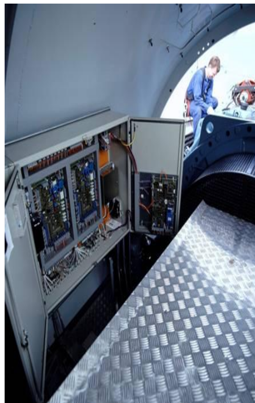
Σχήμα 10.24 Πίνακες ελέγχου ανεμογεννητριών τοποθετημένοι στη βάση (αριστερά) και στην άτρακτο (δεξιά).
