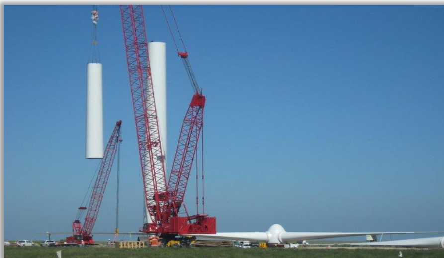
Σχήμα 10.27 Τμηματική τοποθέτηση πύργου ανεμογεννήτριας.
