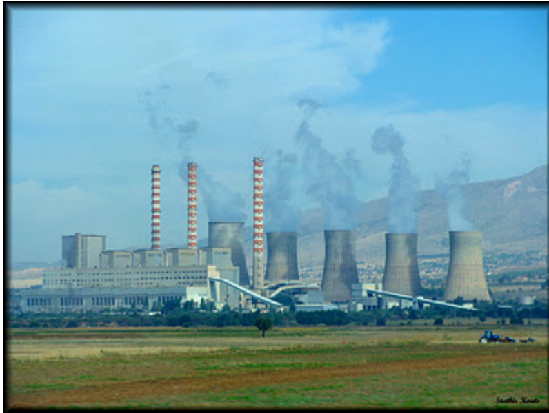
Εικόνα 1.1. Εργοστάσιο παραγωγής ηλεκτρικής ενέργειας με καύση λιγνίτη στην Πτολεμαΐδα.
