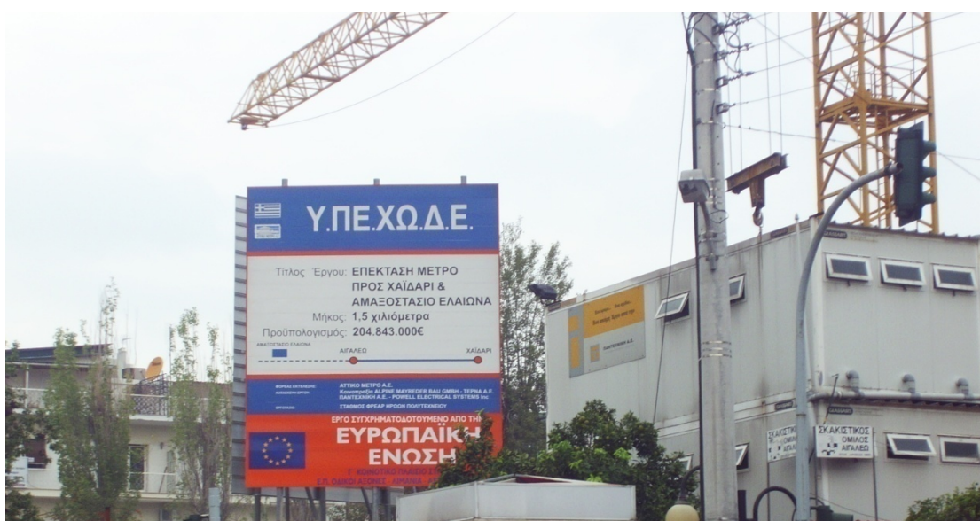
Εικόνα 38. Έργα κατασκευής επέκτασης μετρό με σταθμό έξω από το Δημαρχείο Αιγάλεω.
