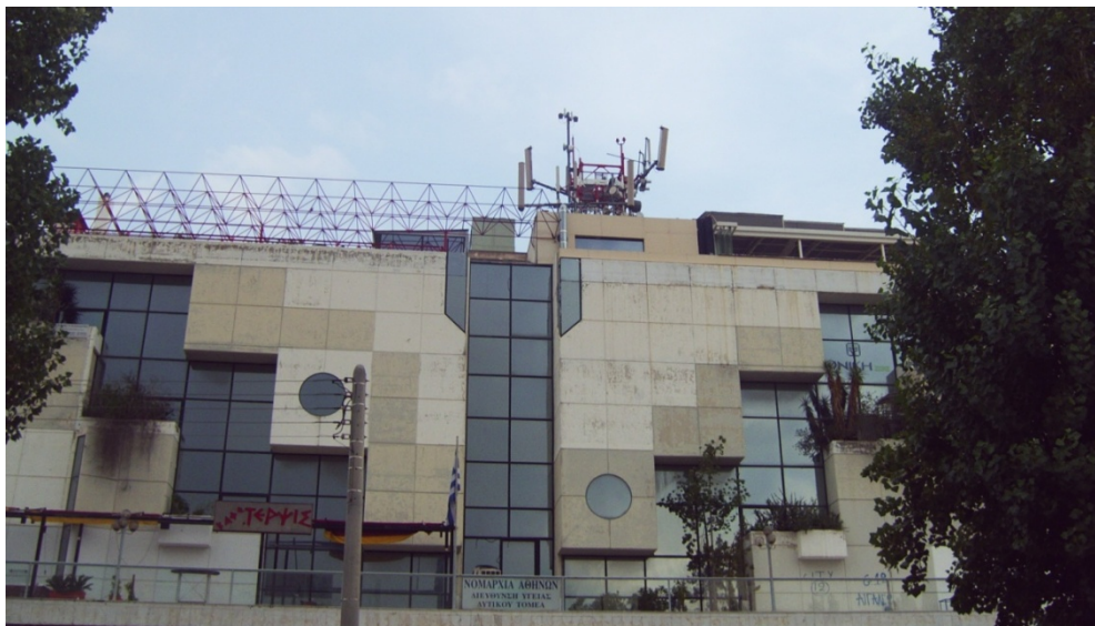
Εικόνα 66. Κεραίες τηλεπικοινωνίας τοποθετημένες σε σχολικό κτιριακό συγκρότημα και στο κτίριο της νομαρχίας Αττικής που βρίσκεται στην Ιερά οδό
