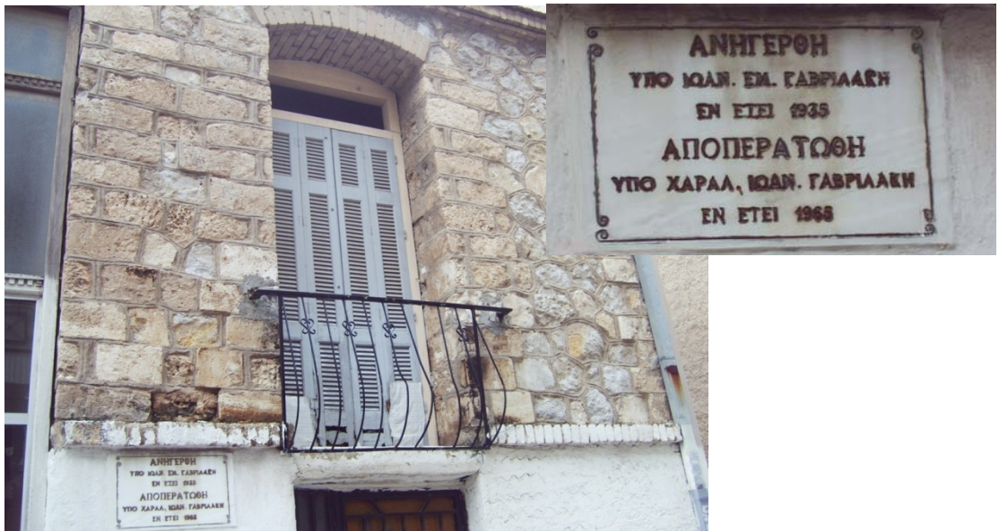
Εικόνα 22. Οι εργασίες για την κατασκευή του κτίσματος ξεκίνησαν το 1935. Το κτίσμα ανεγέρθη τελικώς τη δεκαετία του 60.
