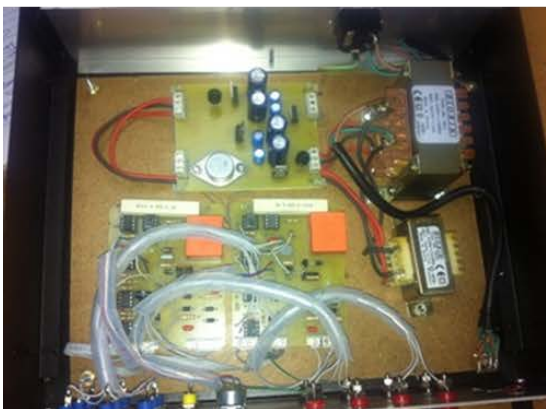
Φωτο 5: Σύνδεση καλωδίων & τοποθέτηση προστατευτικού καλωδίων
