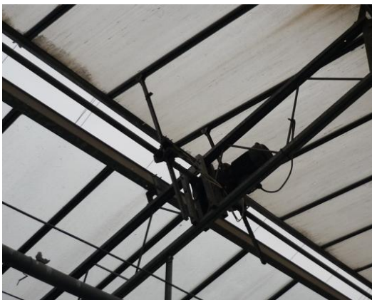
Εικόνα 5: Μηχανισμός λειτουργίας παραθύρου οροφής
