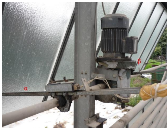
Εικόνα 4: α. Βραχίονας, β. Ηλεκτροκινητήρας με μειωτήρα
