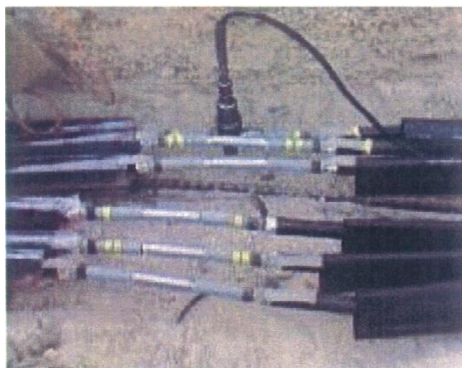
Εικόνα 13 Λεπτομέρεια σύνδεσης αγωγών με δίκτυο ΔΕΗ (αριστερά) και τοποθέτηση αγωγών διασύνδεσης με δίκτυο ΔΕΗ (δεξιά)
