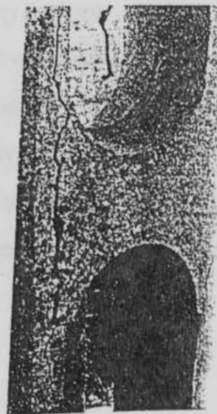
Τοιχίο από σκυρόδεμα. Η μεγάλη ρωγμή αριστερά έχει σχηματιστεί εξαιτίας διάφορων εναλλασσόμενων φορτίων. Η μικρή ρωγμή δεξιά είναι αποτέλεσμα καμπτικής φόρτισης και έχει σχηματιστεί στη ζώνη θλίψης.
