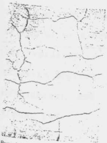
Ρωγμές σε επίχρισμα που οφείλονται στη συρρικνώσή του κατά την ξήρανση
