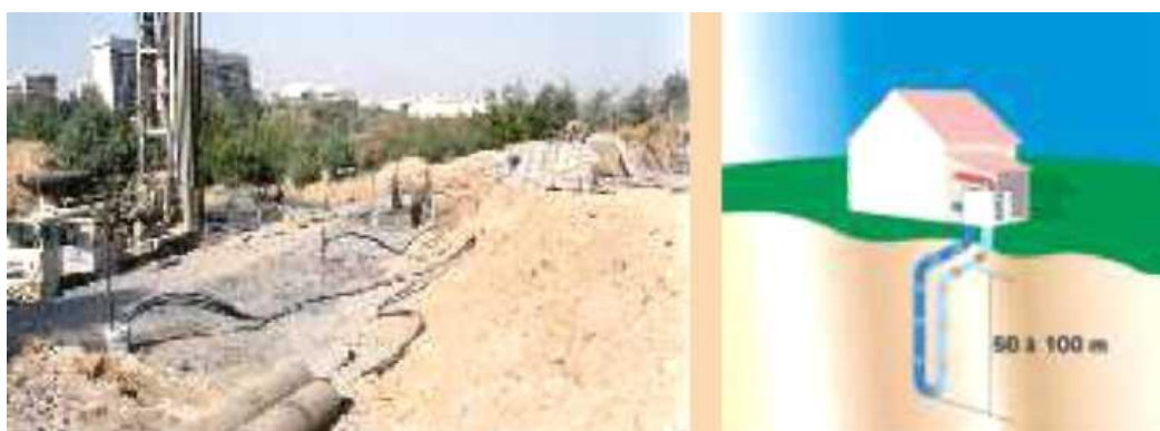
Εικ. 11.Κατακόρυφη διάταξη σωλήνων.
