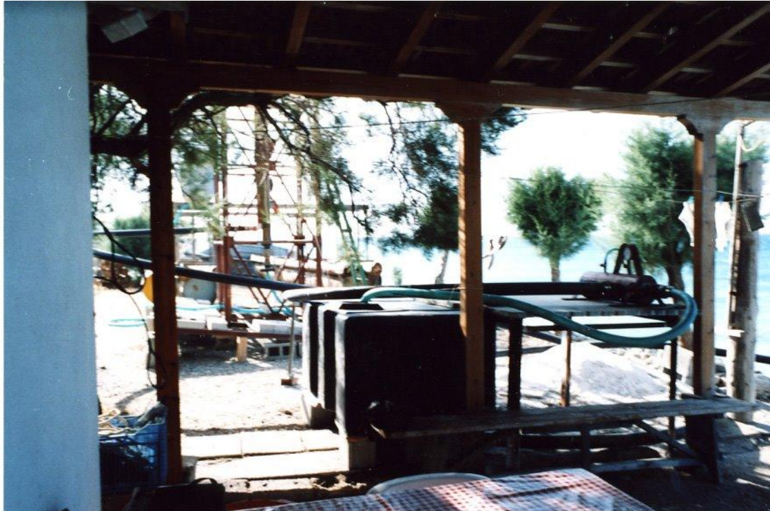
Εικ. 16. Αντλούμενο νερό τοποθετημένο σε λιμνοδεξαμενή.
