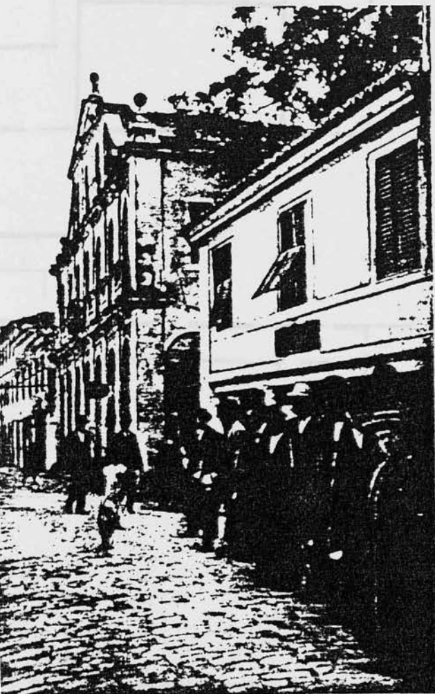
191: Το αβχοντιζό Δομενεγίνη στην «Πλατεία Ρούγα» (Salvator. Το κτήριο είχε ύποστη μεγάλες βες κατὰ τόν τελευταίο πόλεμο: κατεστράφη όμι- ά τó 1953)
