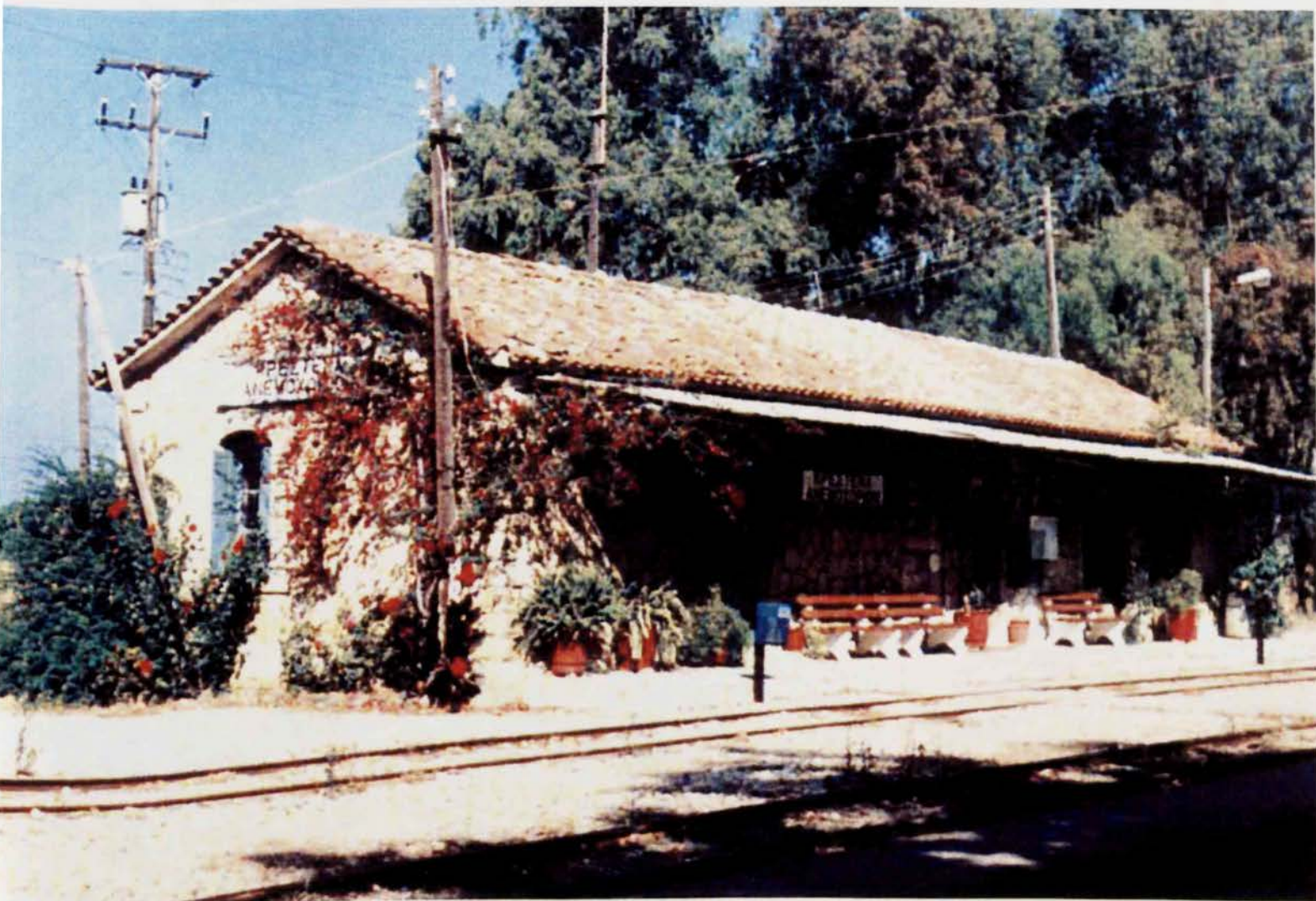
ΦΩΤΟ 18 - ΣΤΑΘΜΟΣ ΚΡΕΣΤΑΙΝΑ
