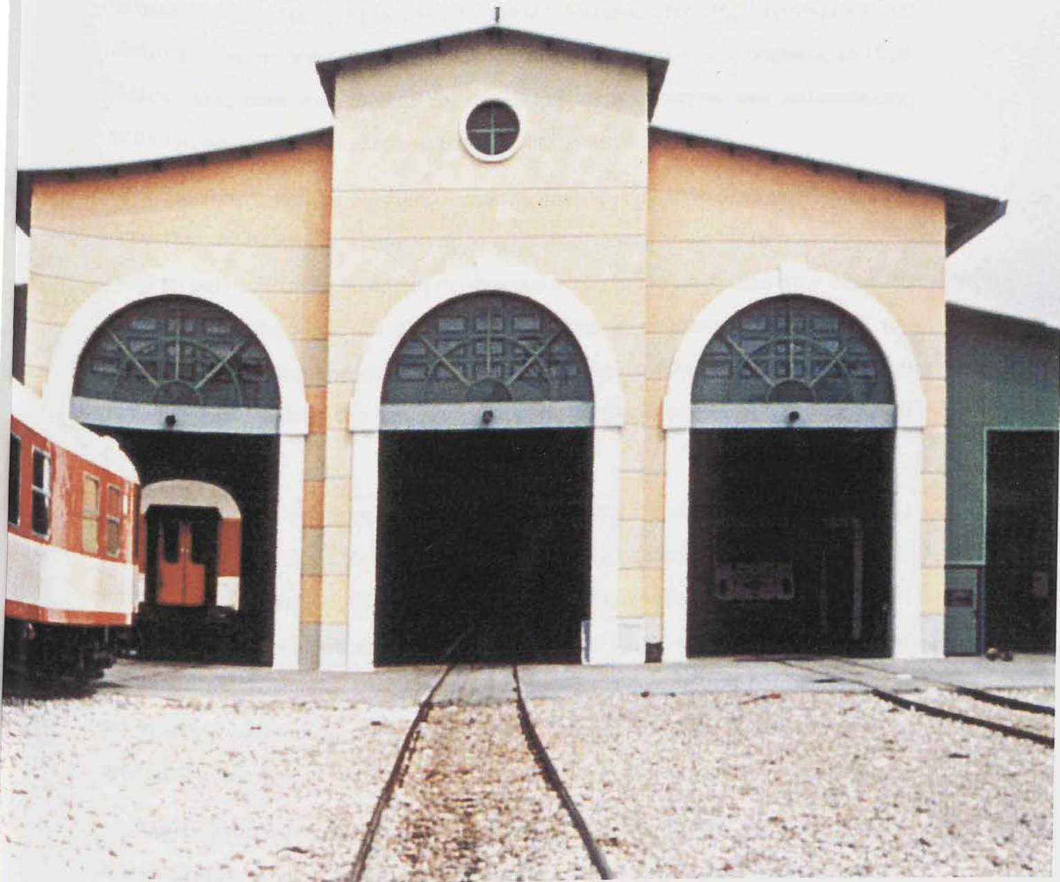
ΦΩΤΟ 67 - ΜΗΧΑΝΟΣΤΑΣΙΟ INTERCITY (PENTHI)
