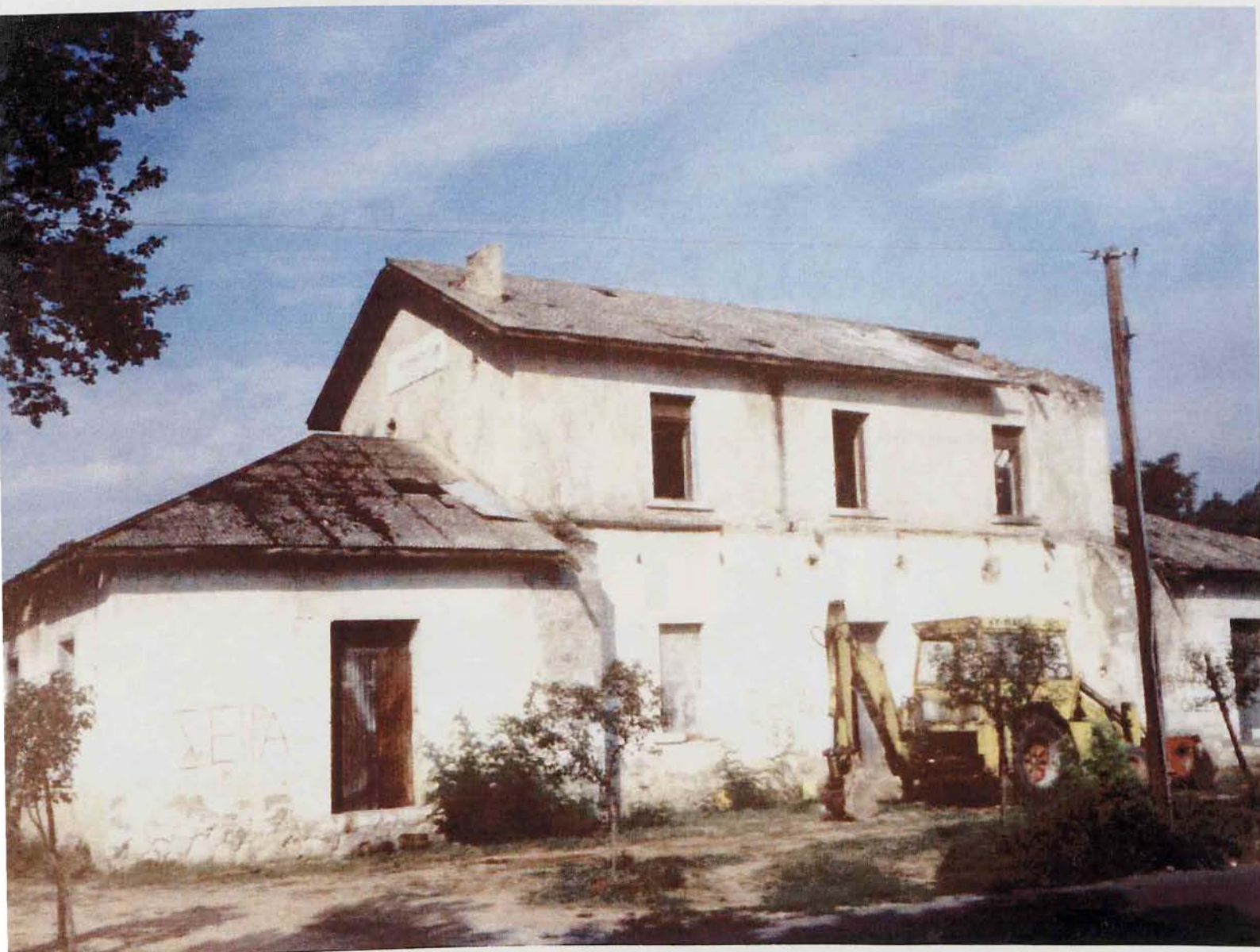
ΦΩΤΟ 42 - ΣΤΑΘΜΟΣ ΣΚΥΔΡΑΣ
