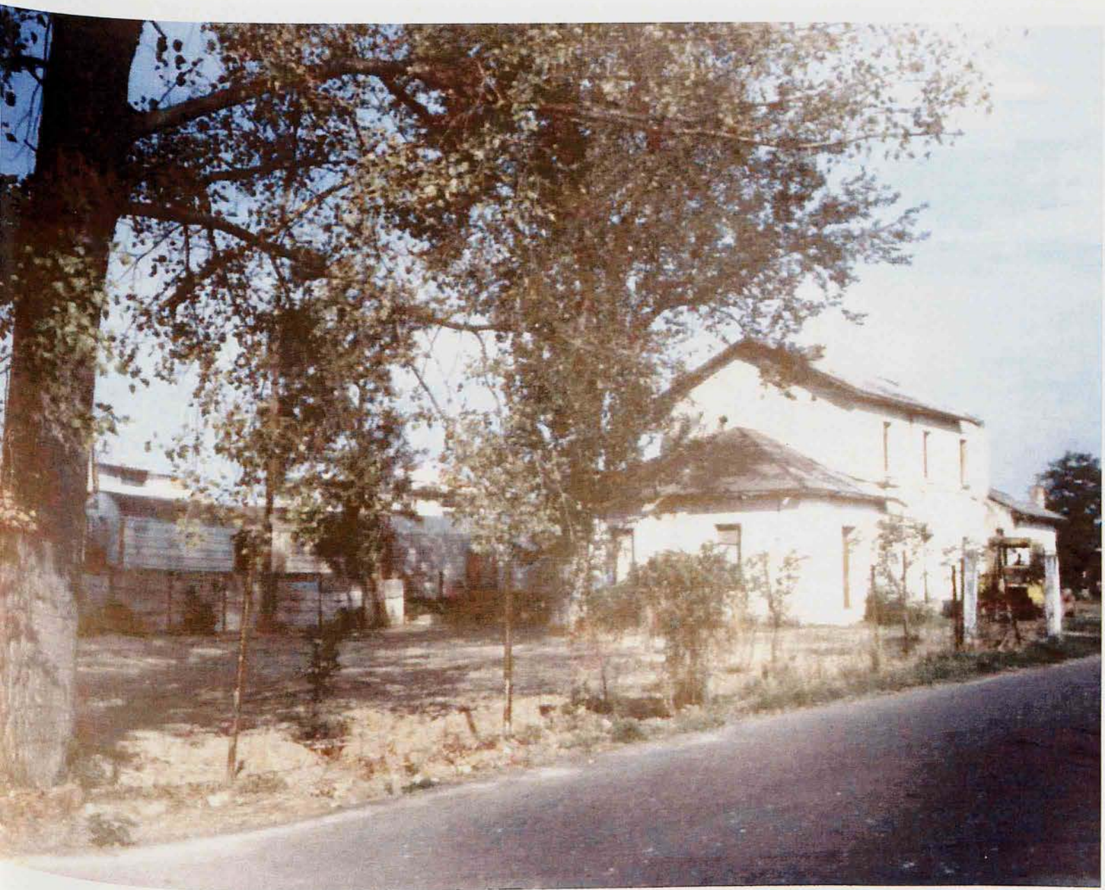
ΦΩΤΟ 50 - ΣΤΑΘΜΟΣ ΣΚΥΔΡΑΣ
