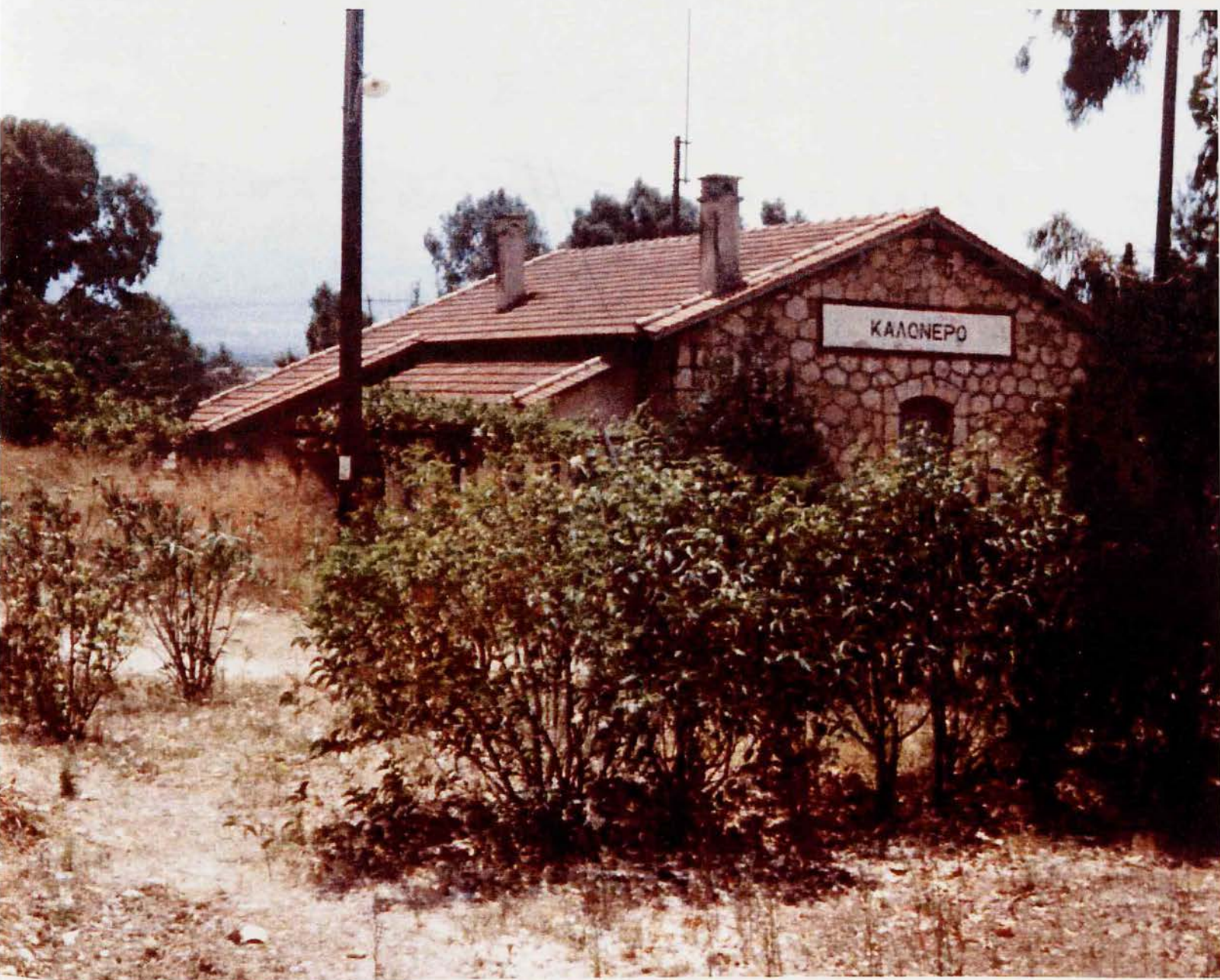
ΦΩΤΟ 22 - ΣΤΑΘΜΟΣ ΚΑΛΟΝΕΡΟΥ
