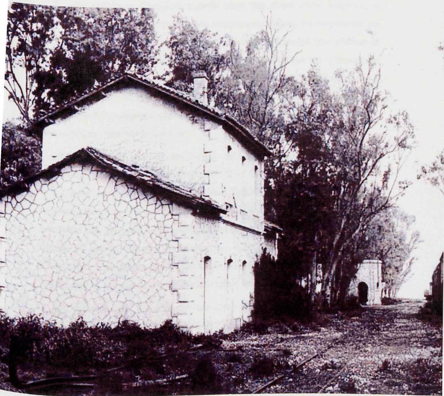
ΦΩΤΟ 29 - ΣΤΑΘΜΟΣ ΚΡΥΟΝΕΡΙΟΥ
