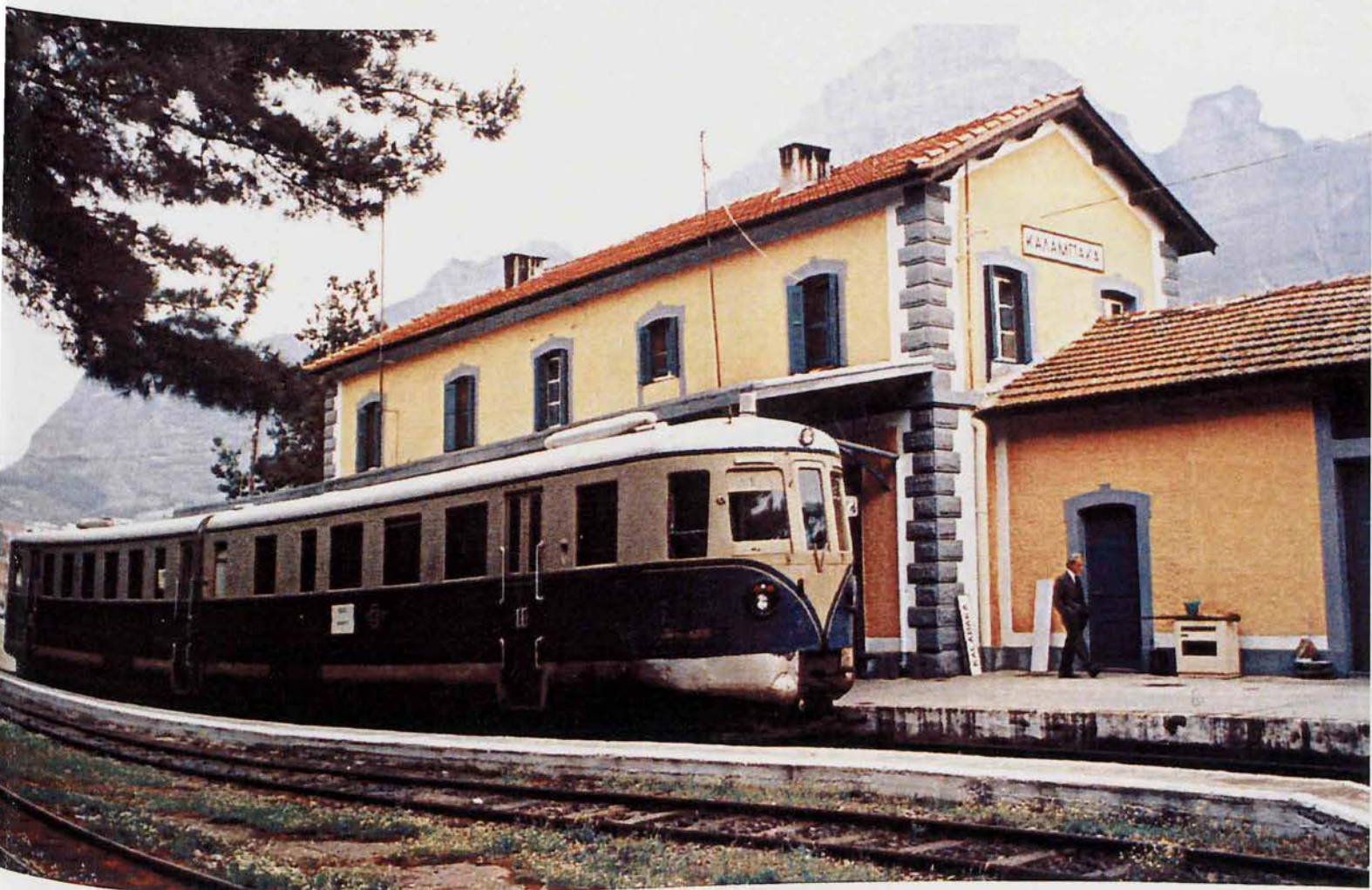
ΦΩΤΟ 38 - ΣΤΑΘΜΟΣ ΚΑΛΑΜΠΙΑΚΑΣ
