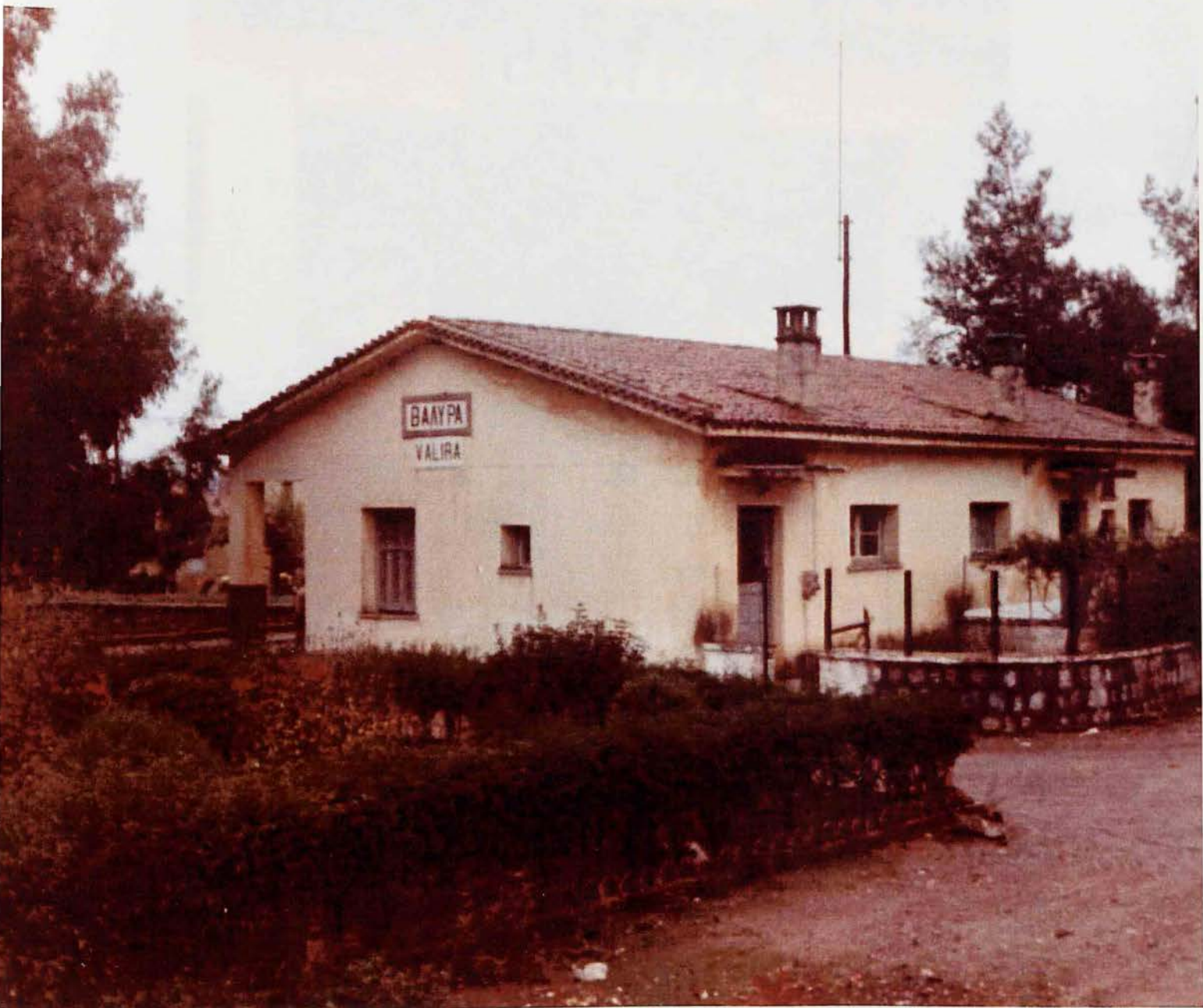
ΦΩΤΟ 25 - ΣΤΑΘΜΟΣ ΒΑΛΥΡΑΣ
