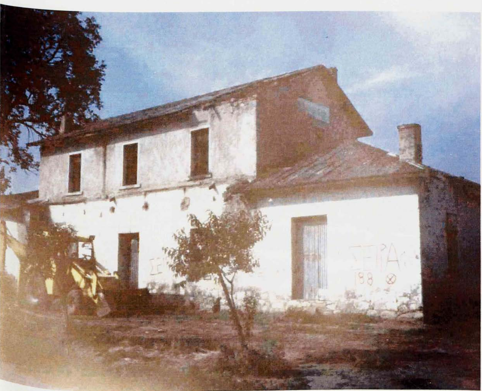
ΦΩΤΟ 51 - ΣΤΑΘΜΟΣ ΣΚΥΔΡΑΣ
