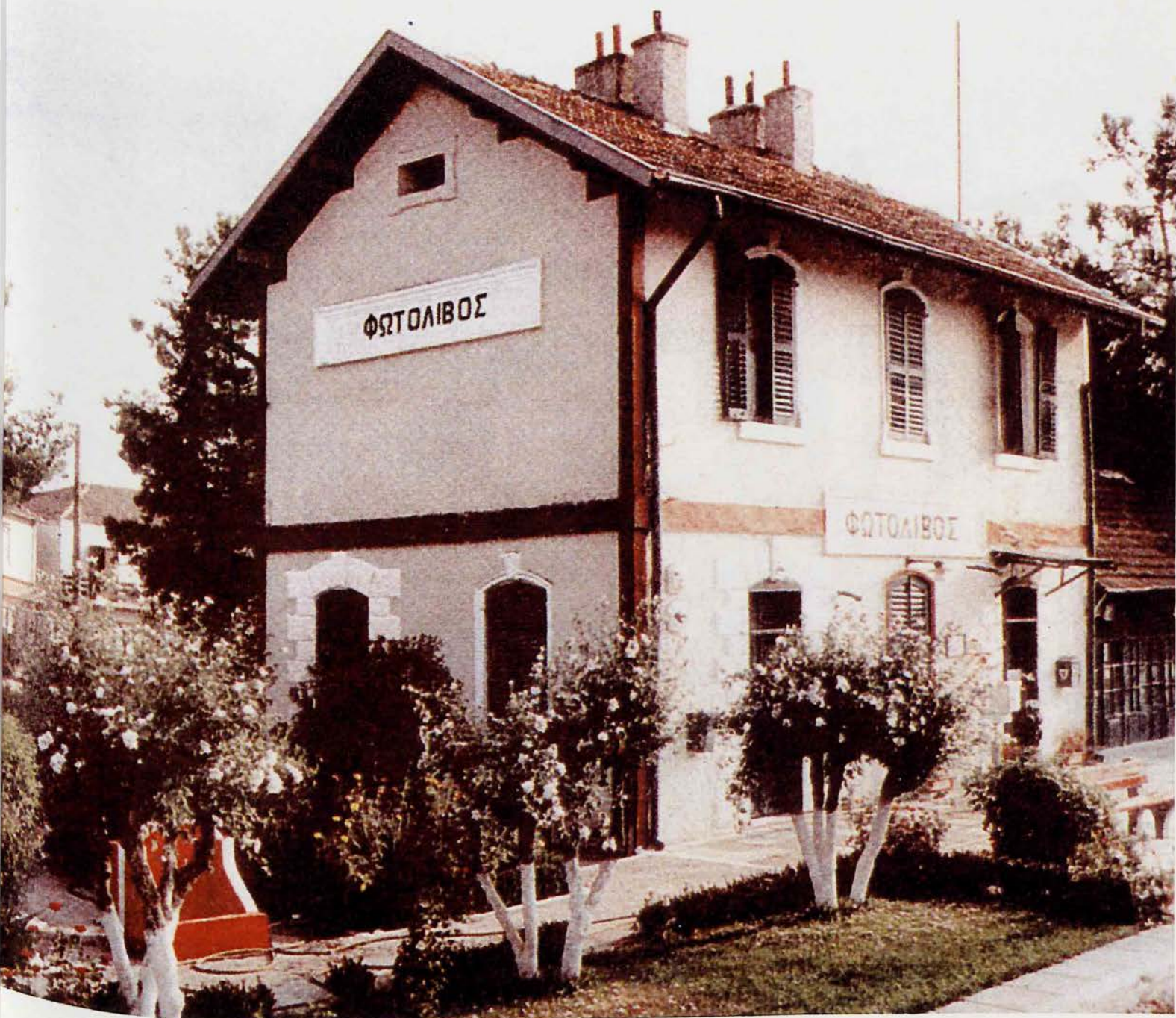
ΦΩΤΟ 57 - ΣΤΑΘΜΟΣ ΦΩΤΟΛΙΒΟΣ
