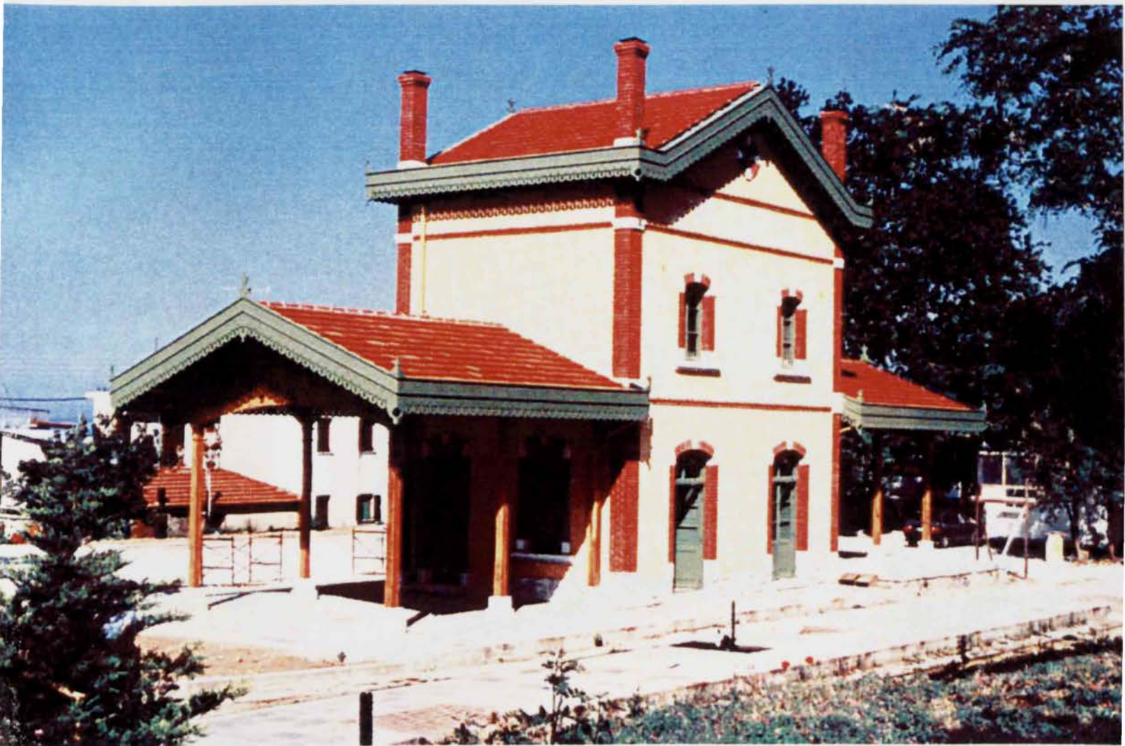
ΦΩΤΟ 36 - ΣΤΑΘΜΟΣ ΛΕΧΩΝΙΩΝ - ΝΕΟ ΚΤΙΡΙΟ
