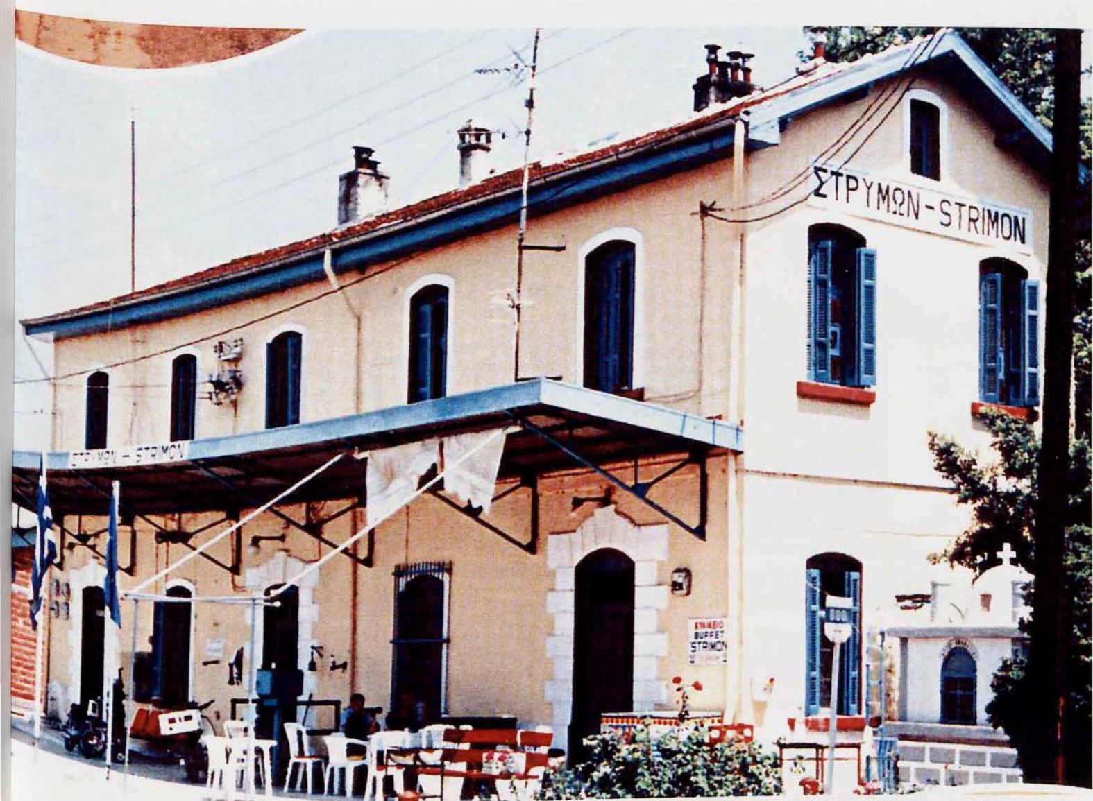
ΦΩΤΟ 59 - ΣΤΑΘΜΟΣ ΣΤΡΥΜΩΝΑ
