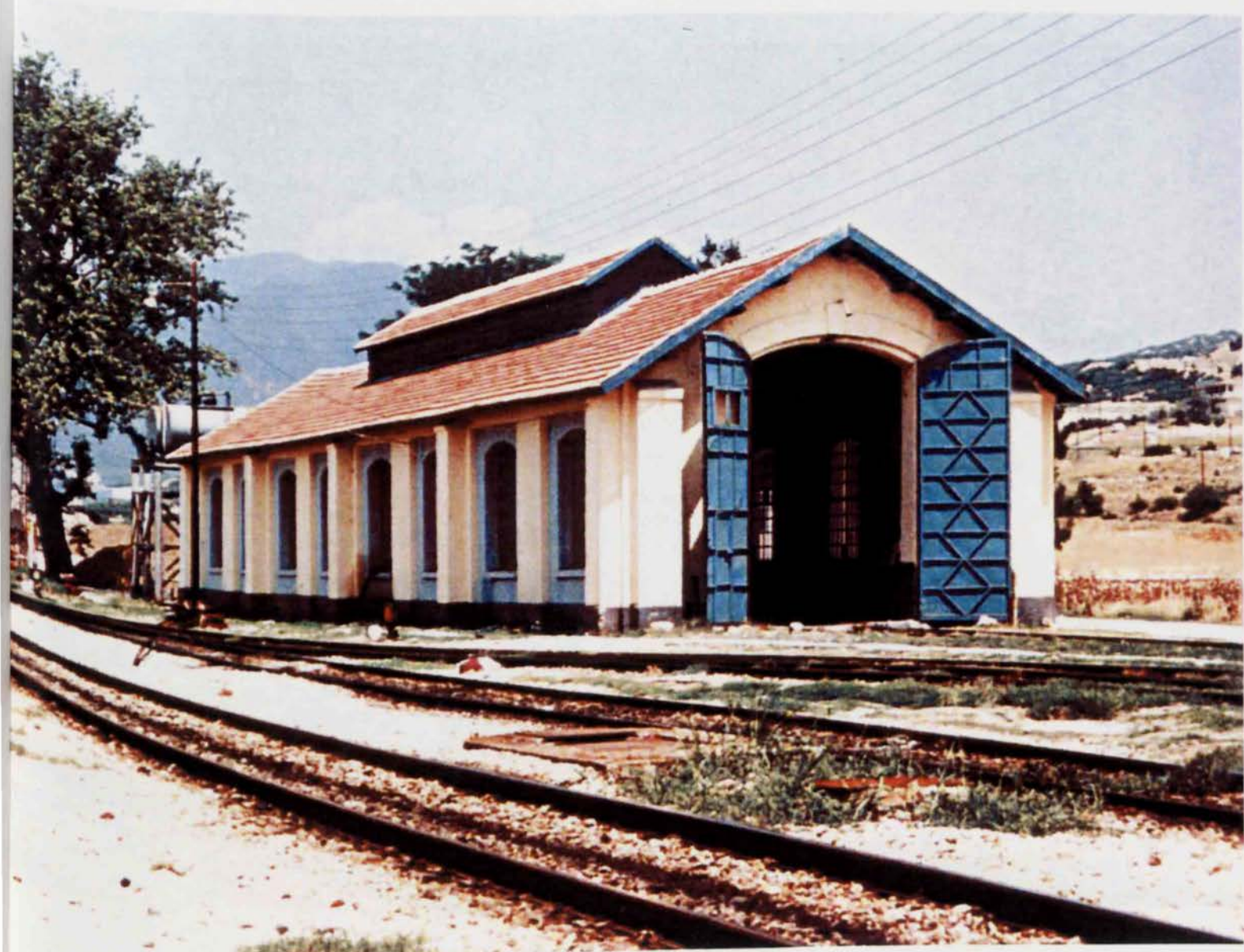
ΦΩΤΟ 60 - ΣΤΑΘΜΟΣ ΣΤΡΥΜΩΝΑ - ΜΗΧΑΝΟΣΤΑΣΙΟ
