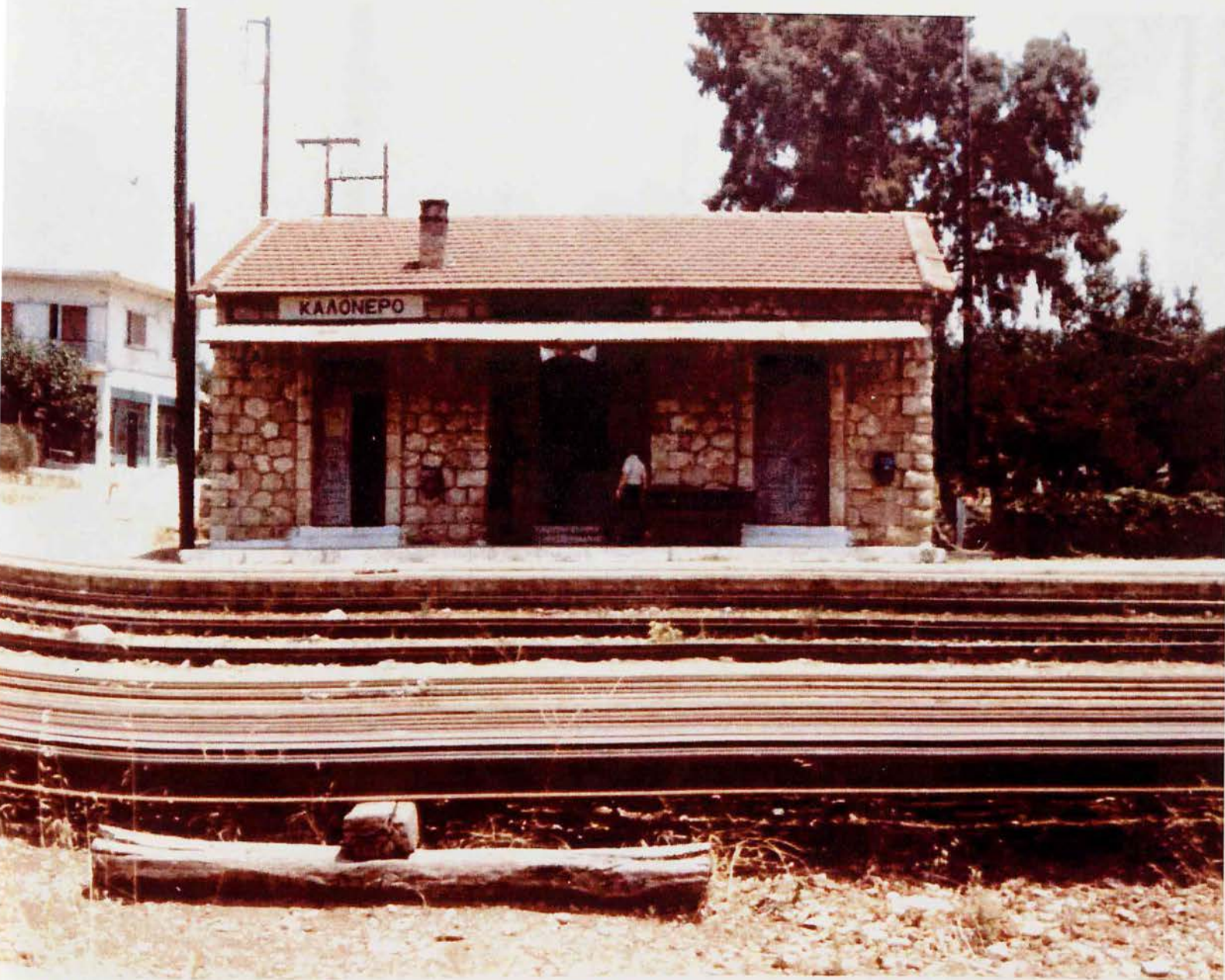
ΦΩΤΟ 21 - ΣΤΑΘΜΟΣ ΚΑΛΟΝΕΡΟΥ
