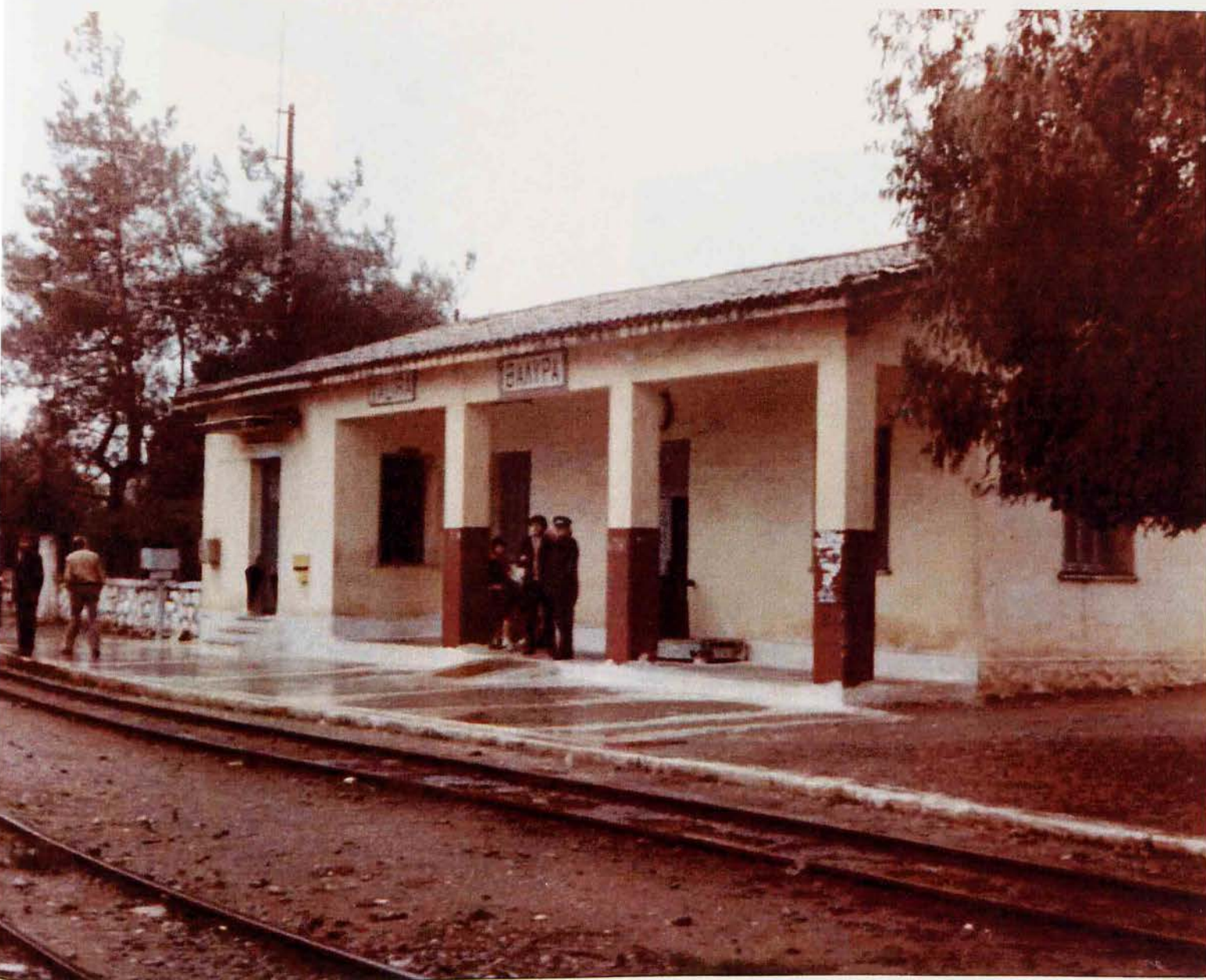
ΦΩΤΟ 23 - ΣΤΑΘΜΟΣ ΒΑΛΥΡΑΣ
