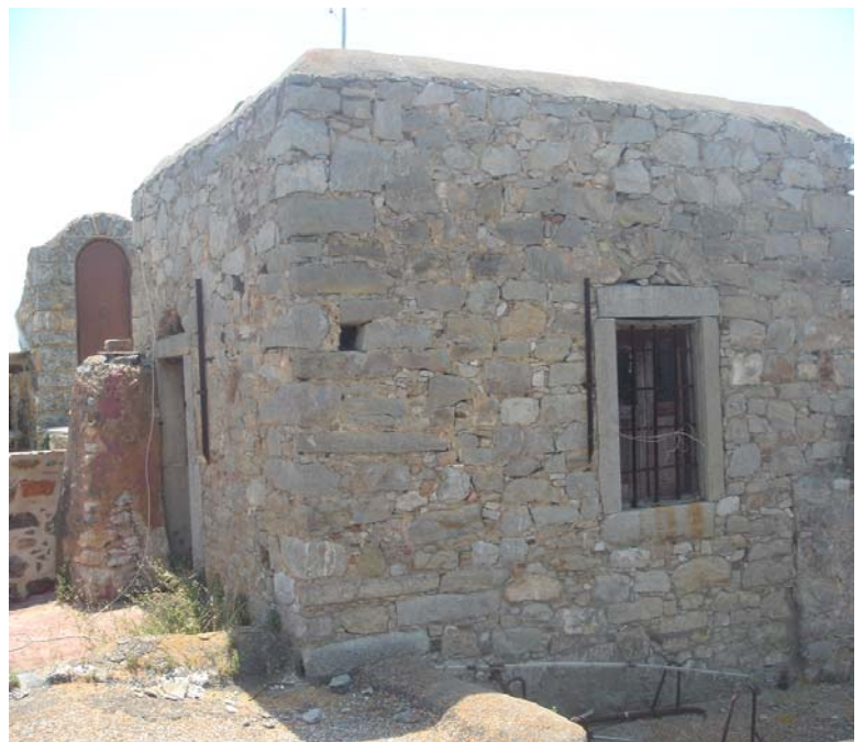
Εικ. 56 : Εξωτερικά παράθυρα όπου φαίνονται τα πρέκια, τόξα και οι ποδιές . Πηγή : Ιδία επεξεργασία
