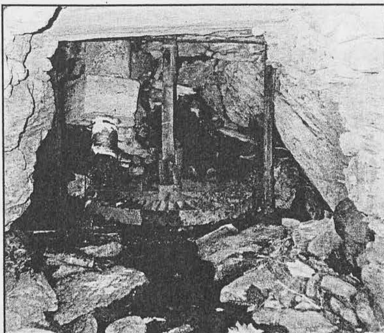
Εικόνα 78: Η φτερωτή του νερόμυλου, όπου φαίνονται το σιφούνι και η σταματήτρα στα αριστερά και η σηκωτήρα στα δεξιά
