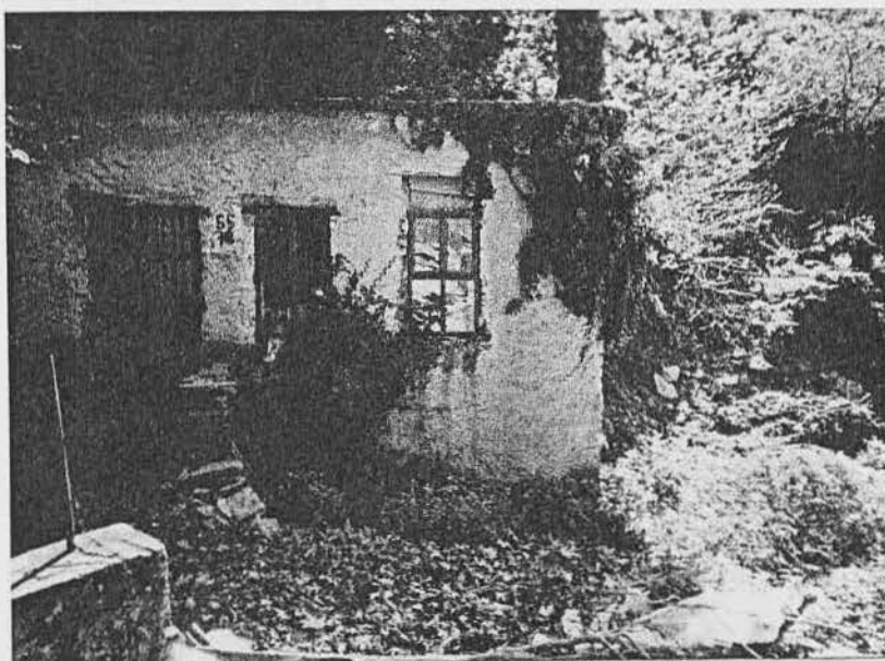
Φωτογραφία 3:Πρόσοψη μύλου.Φαίνονται καθαρά τα τέσσερα ανοίγματα.
