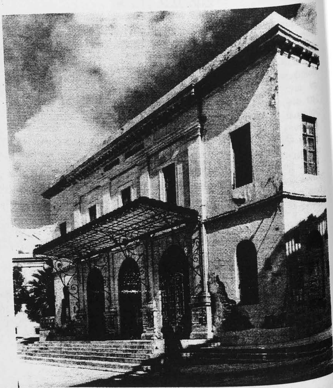
εικ.16 (Πρόσοψη Θεάτρου «Απόλλων» - πριν την επισκευή)
