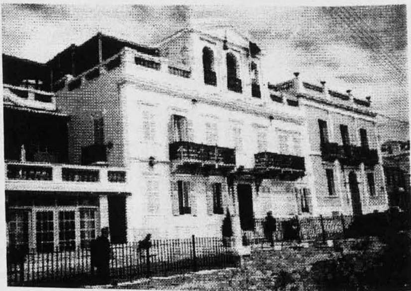
εικ.19 (Νεοκλασικό κτίριο)
