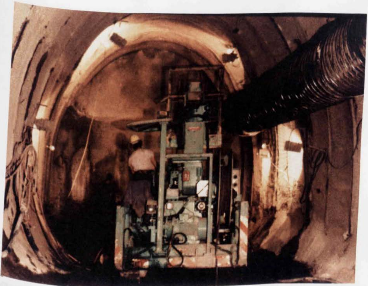
Εσωτερικό σήραγγας όπου εφαρμόζεται το εκτοξευόμενο ινοπλισμένο σκυρόδεμα
