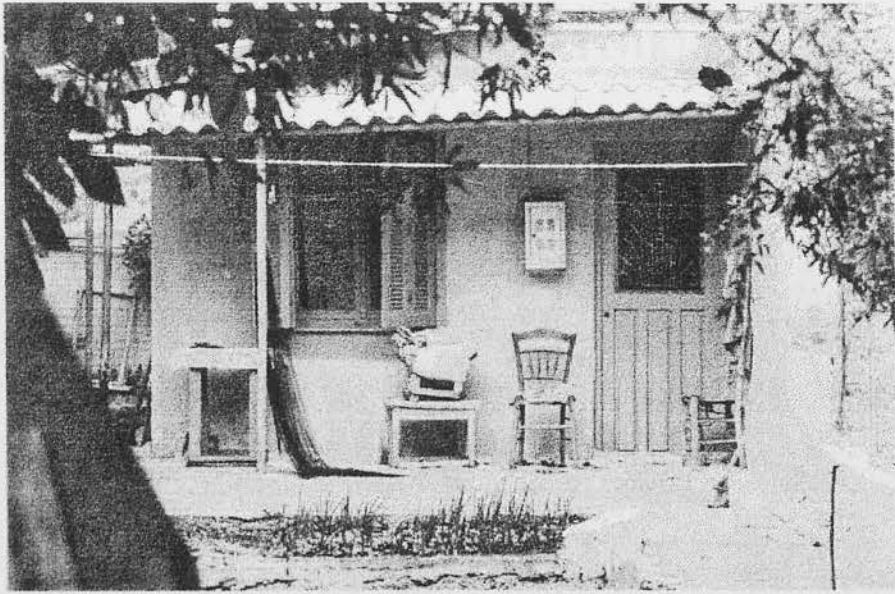
016. ΚΤΙΣΜΑ ΣΤΗΝ ΑΡΧΙΚΗ ΜΟΡΦΗ. Η ΣΚΕΠΗ ΑΠΟ ΛΑΜΑΡΙΝΑ ΦΑΙΝΕΤΑΙ ΚΑΘΑΡΑ
