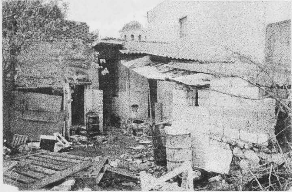
014. ΕΓΚΑΤΑΛΕΛΕΙΜΜΕΝΟ ΚΤΙΣΜΑ ΤΥΠΟΥ Α'
