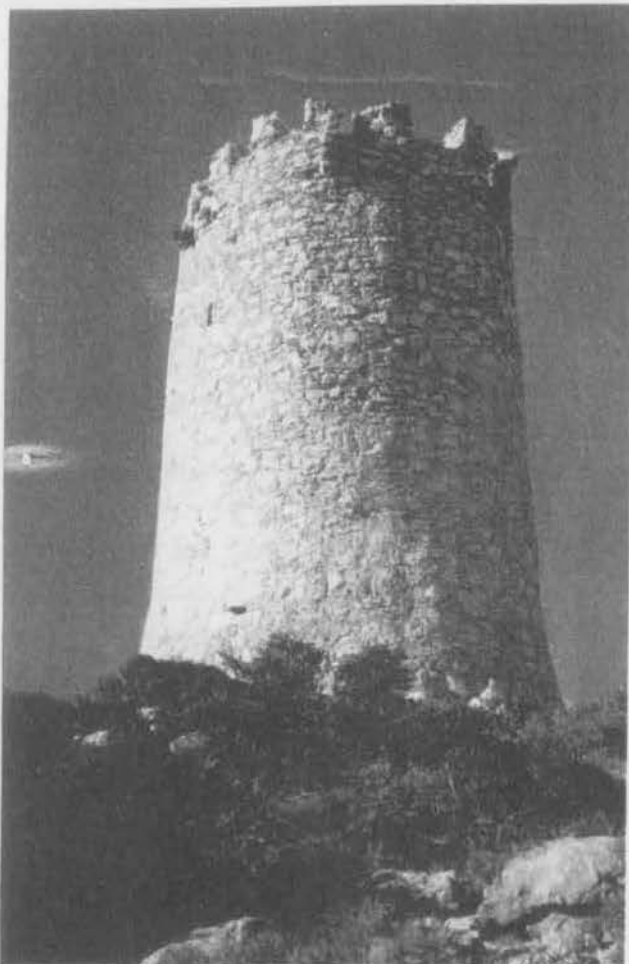
Εικόνα 17 : Βορινή πλευρά της βίγλας στο Λιβάδι Μεστών
