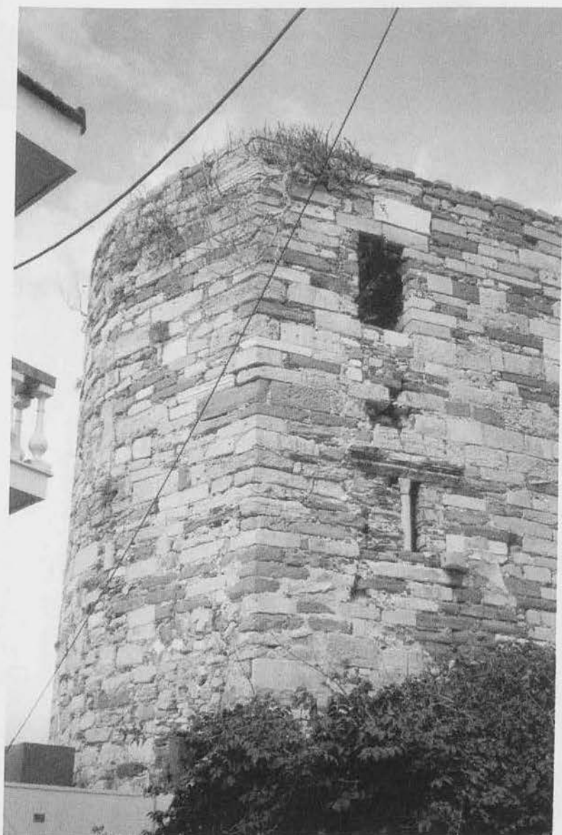
Εικόνα 19 : Νοτιοδυτική πλευρά του πύργου του Κουλά. Διακρίνεται η είσοδος του δώματος και το ημικυλινδρικό σχήμα του.
