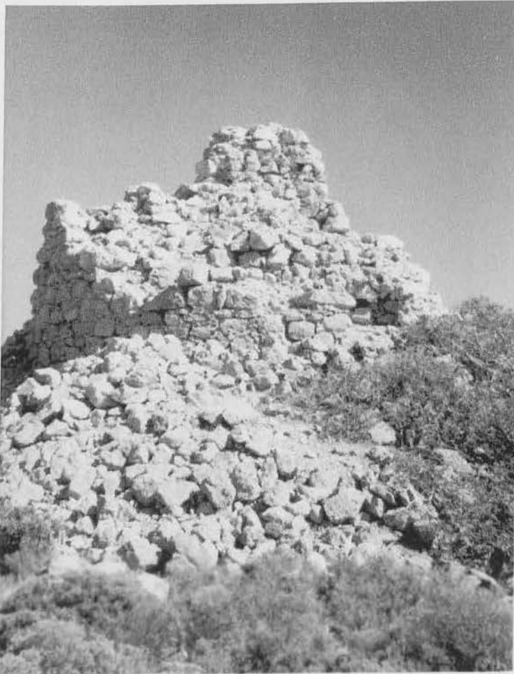
Εικόνα 67 : Δυτική πλευρά της βίγλας των Κάτω Φανών.
