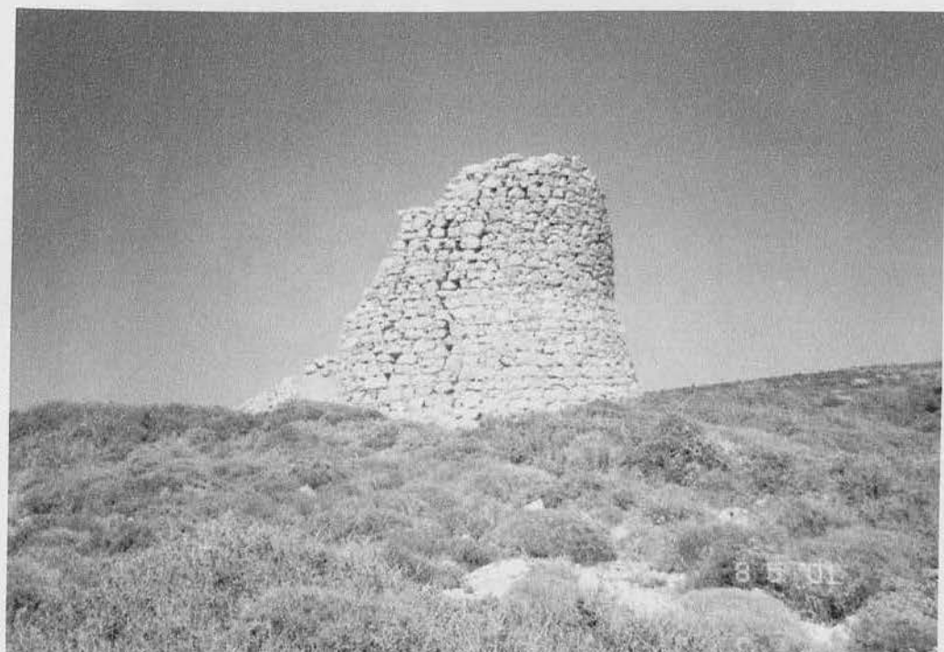
Εικόνα 66 : Ρωγμές και σημάδια κατάρρευσης στα τοιχώματα της νότιας πλευράς της βίγλας της Αγίας Δύναμης.
