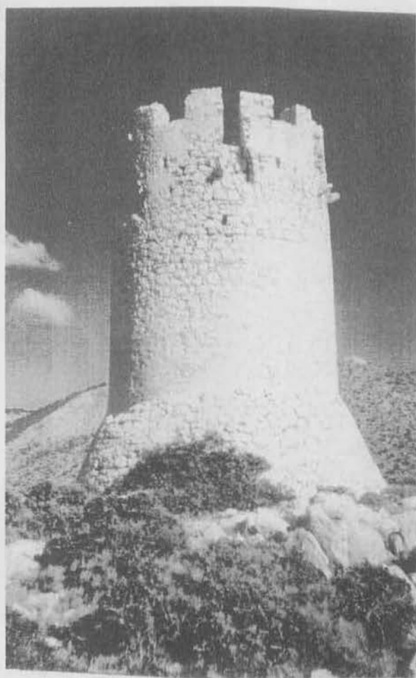
Εικόνα 15 : Νότια όψη της βέγλας του Τραχηλιού.
