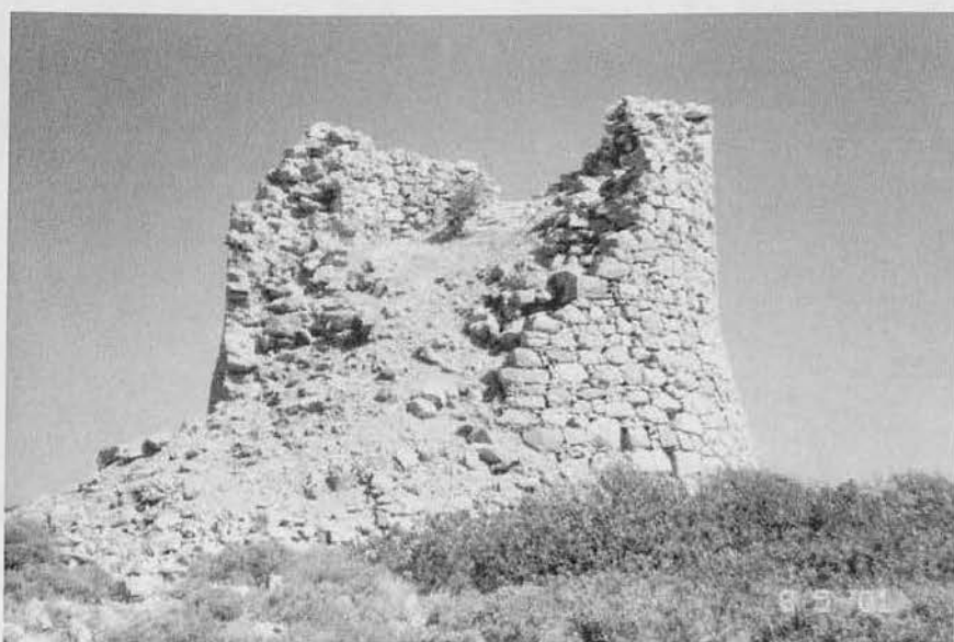
Εικόνα 64 : Η κατάρρευση της δυτικής πλευράς της βίγλας.
