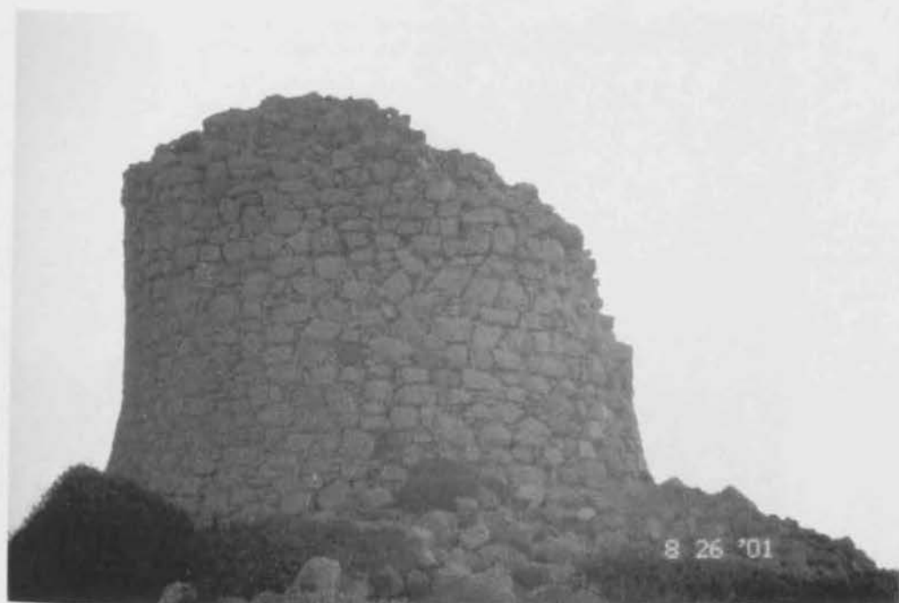
Εικόνα 59 : Δυτική πλευρά της βίγλας στα Τραχήλια Μεστών.
