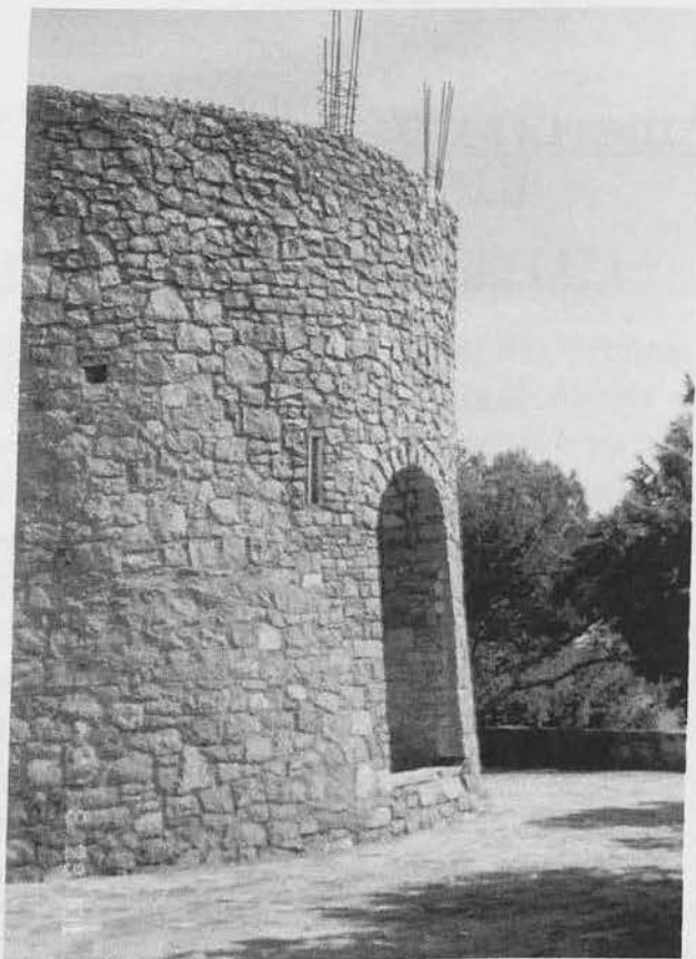
Εικόνα 23 : Διακρίνεται στην δυτική της πλευρά μια είσοδος , μετά την ανακατασκευή της βίγλας.
