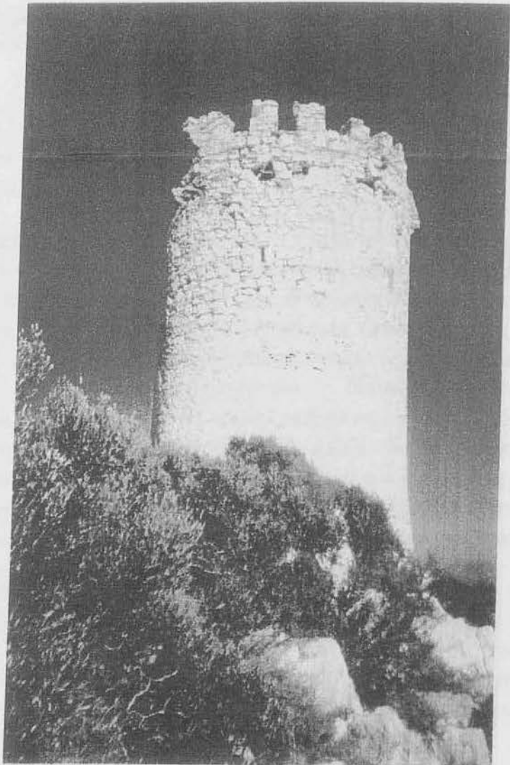
Εικόνα 18 : Νότια όψη της βίγλας των Μεστών
