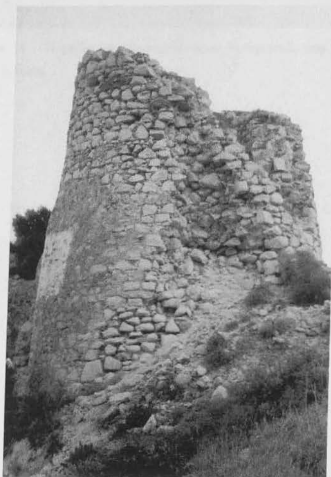
Εικόνα 33 : Κατάρρευση της δυτικής πλευράς της βίγλας.
