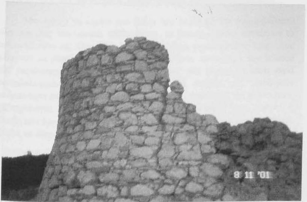
Εικόνα 41 : Βορεινή πλευρά της βίγλας.
