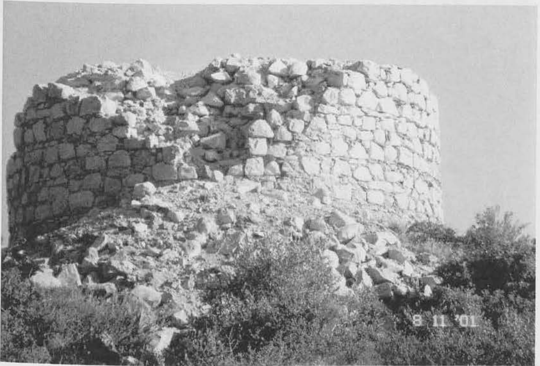
Εικόνα 72 : Βόρεια πλευρά της βίγλας του Εμπορίου.
